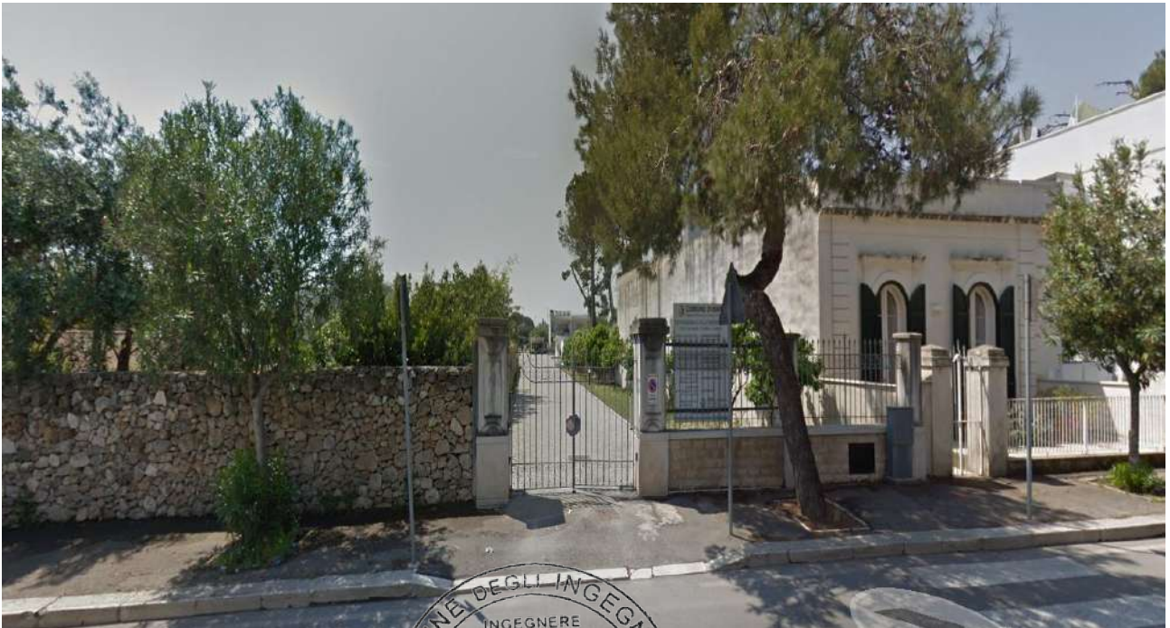
foto n.01 – Ingresso Carrabile – via Bari
