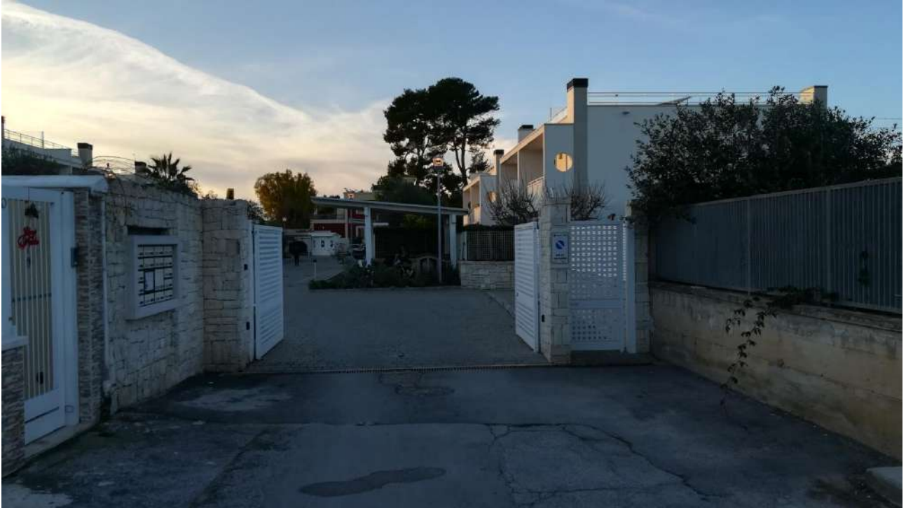
foto n.01 – Ingresso Carrabile – via Macalle11
