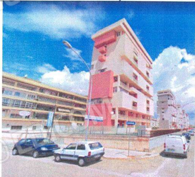
Vista esterna del complesso edilizio di cui l'unità oggetto di stima costituiscono porzione - Vista da Via Monte Rosa
