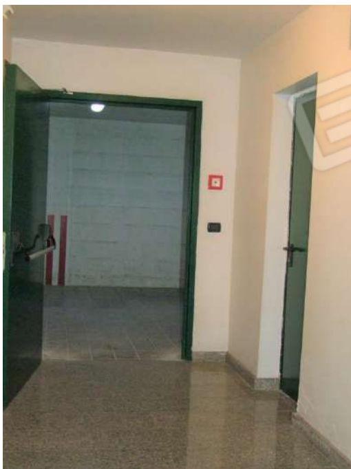
Foto 34 - Vista della porta della cantinola dal percorso di accesso condominiale
