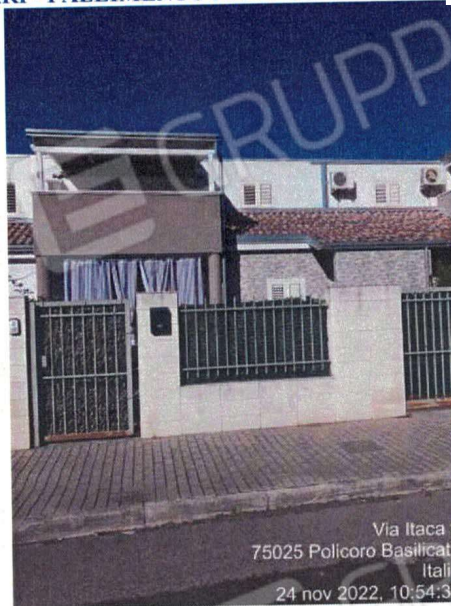
Foto N. 1,...51 prodotte in data 24/11/2022 – Immobile via Itaca in Marina di Policoro (PZ)
