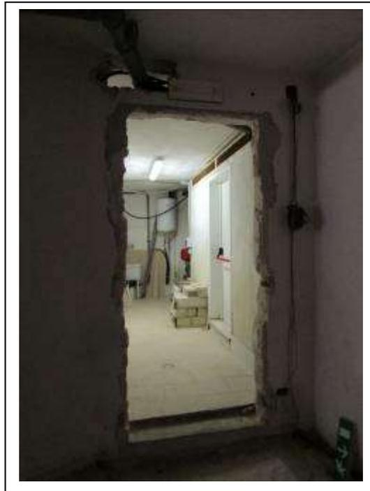
e) Ripristino della scala interna di comunicazione tra i piani terra e interrato, mediante demolizione delle chiusure orizzontali e verticali esistenti.
