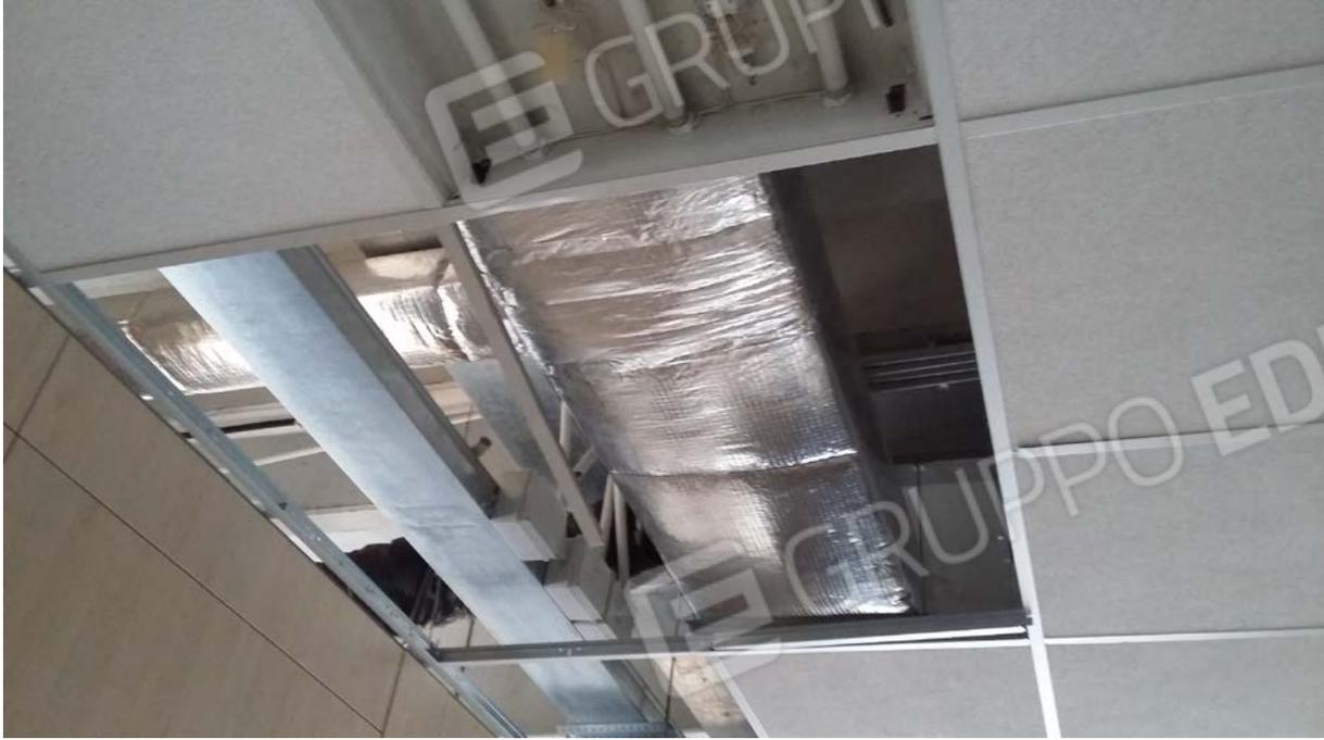
**Foto 124 - Particolare canale metallico distribuzione impianto elettrico.**
