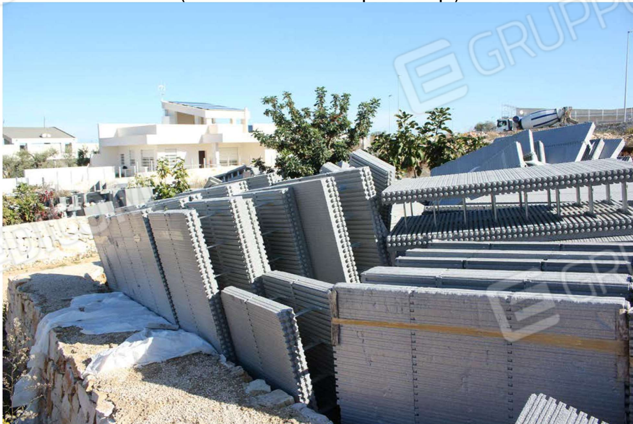
Foto 2 (Vista dei blocchi/cassero a perdere in eps)
