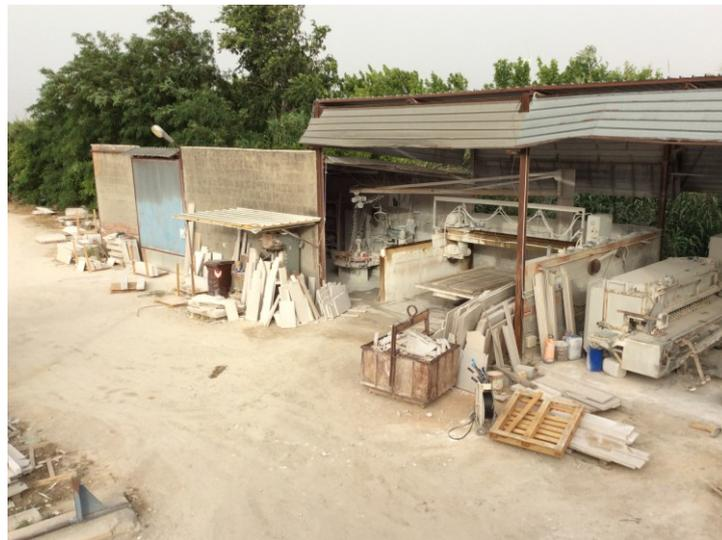
Si sono riscontrate, inoltre, due strutture leggere – tettoie. Indentificate nella planimetria catastale con le lettere “A” e “G”. Entrambe sono costituite da telai portanti scatolari in ferro con copertura in lamiera gregata. Una è disposta all’ingresso dell’area dell’opificio, in adiacenza agli uffici ed è utilizzata come tettoia di protezione dell’area parcheggio
