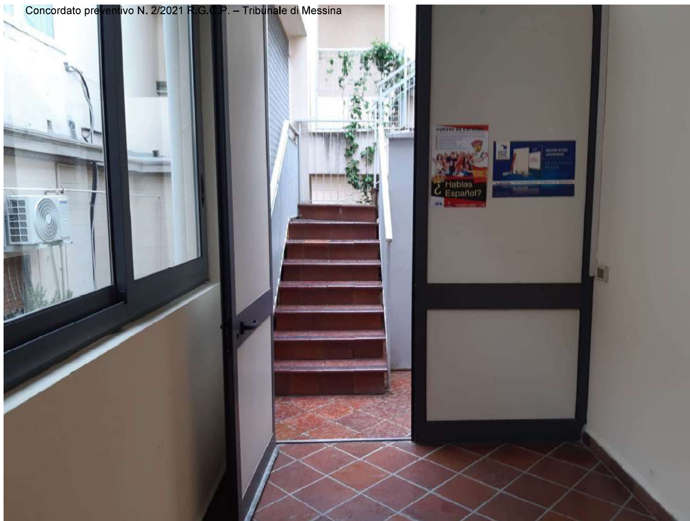
Foto n°2: MESSINA – VIALE SAN MARTINO N.146 – PIANO TERZO – APPARTAMENTO CON DESTINAZIONE D’USO UFFICIO - foglio 229 part. 118 sub 24 La foto indica l’accesso all’unità immobiliare da ballatoio esterno.
