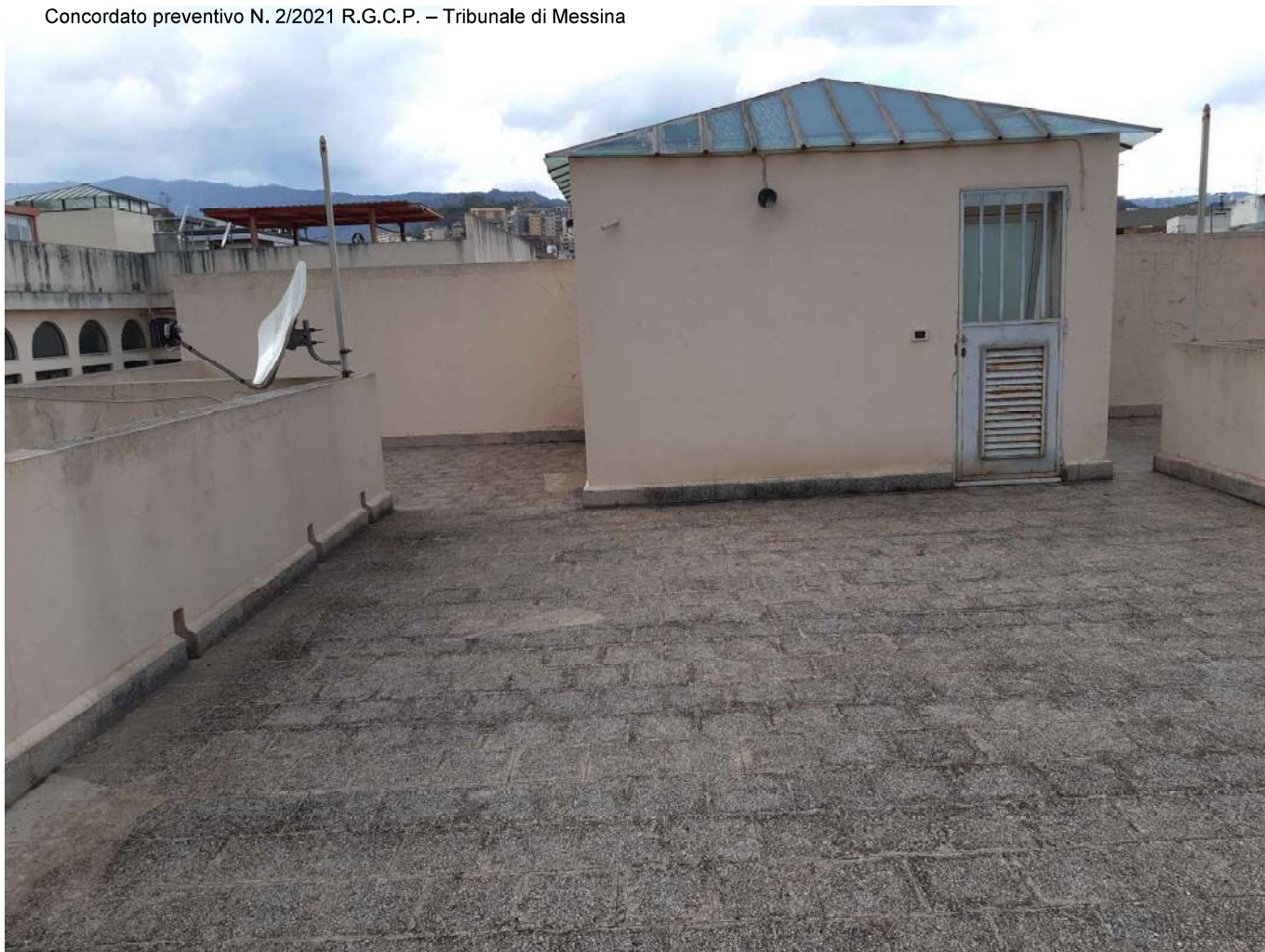
Foto n°8: MESSINA – VIALE SAN MARTINO N.146 – PIANO QUARTO – LASTRICO SOLARE - foglio 229 part. 118 sub 33 Lastrico solare
