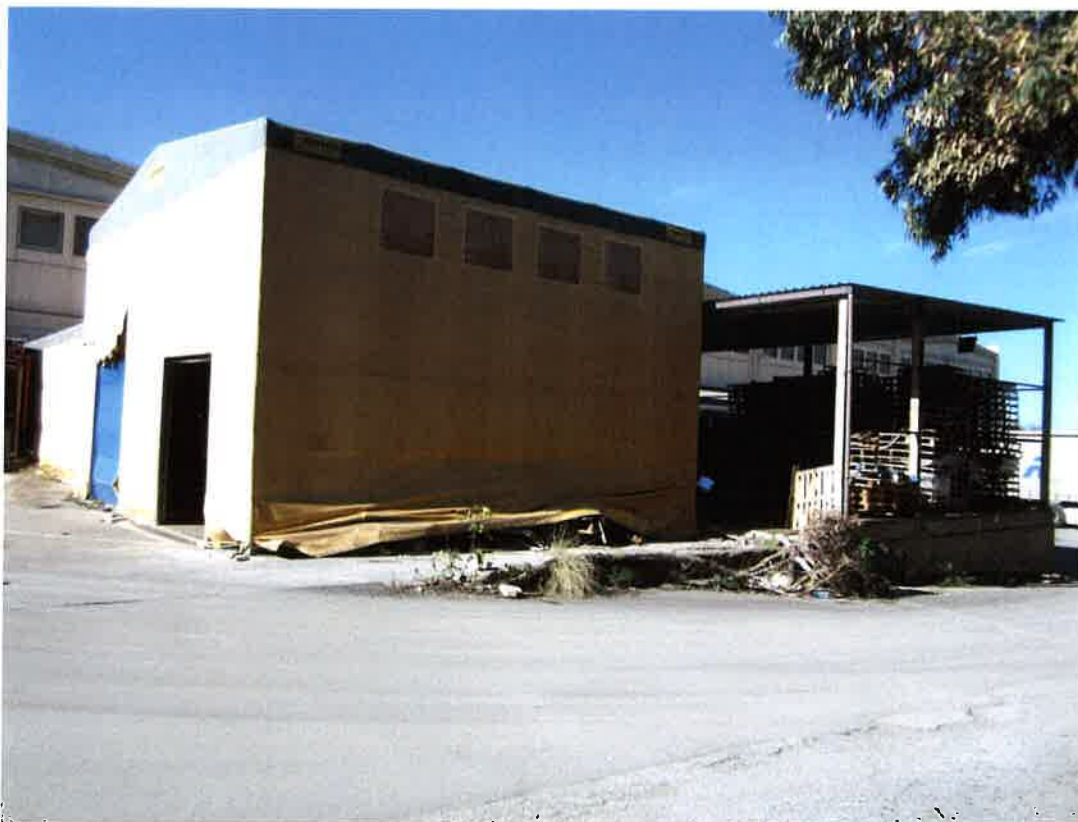
Foto 39: le tettoie ed i manufatti destinati a magazzino/ricovero merci, ad est del complesso, dei quali ho previsto la rimozione, in quanto privi di atti autorizzativi
