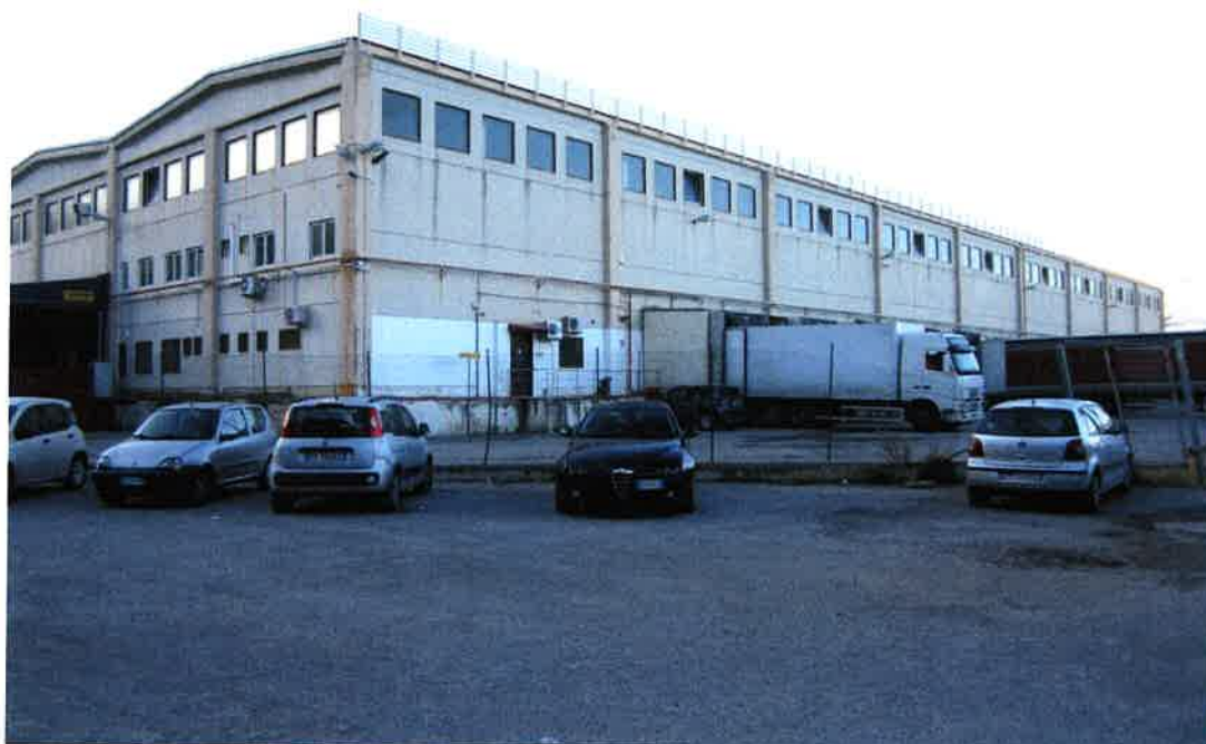
Foto 4: panoramica del capannone ad est del complesso immobiliare a destinazione commerciale/logistica, identificato nell'intero, nel foglio 5, dalle particelle 894 sub. 4-5-6
