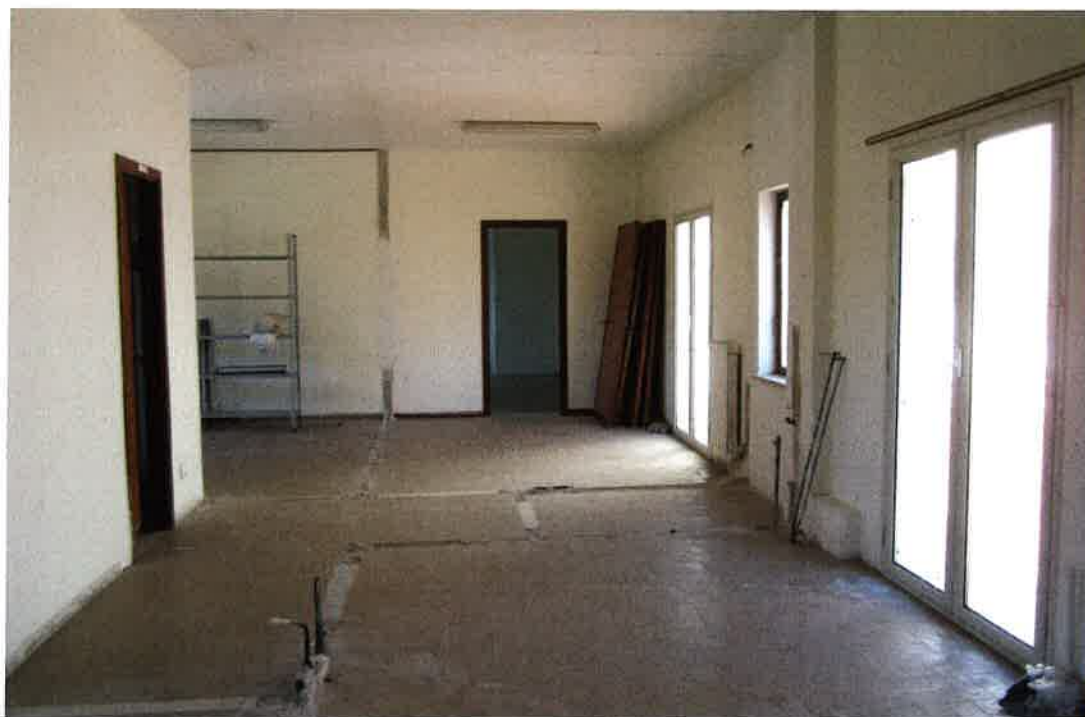
Foto 30: altri ambienti al primo piano del capannone ubicato ad ovest del complesso, già adibiti a spogliatoi e servizi, oggi dismessi e non utilizzati
