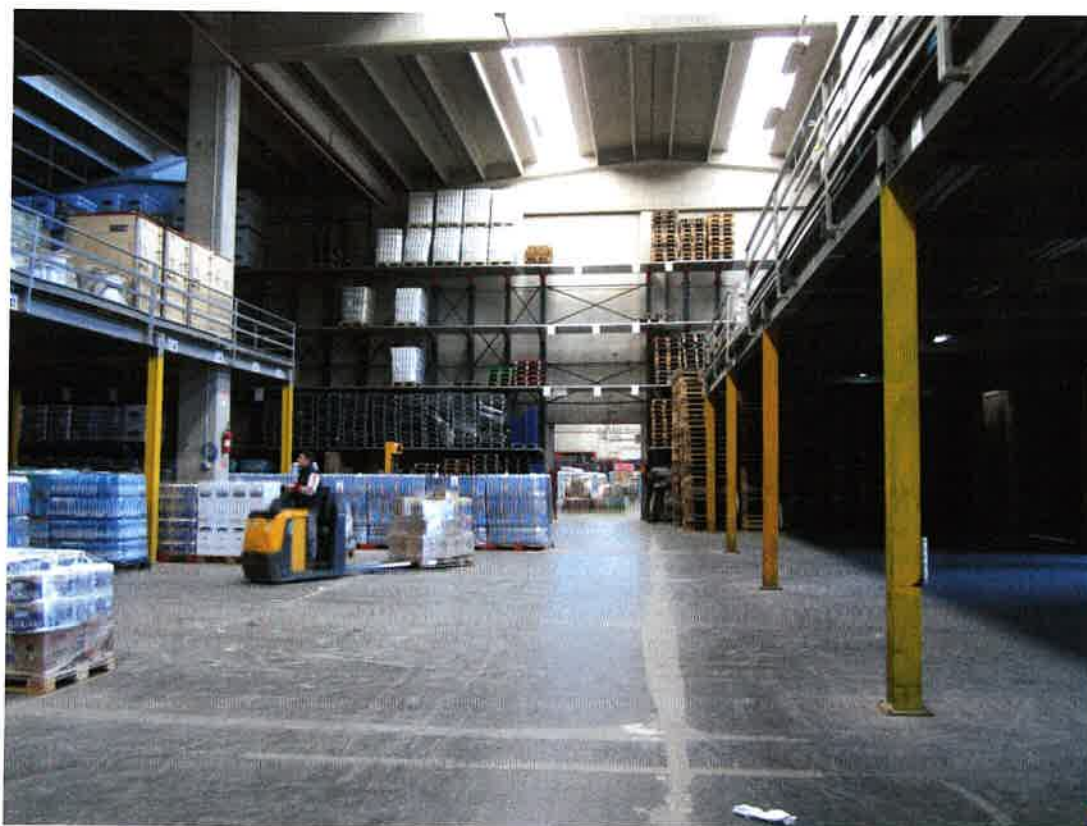
Foto 10: altra panoramica interna del capannone ubicato ad est del complesso immobiliare a destinazione commerciale/logistica; anche in questo caso, perimetralmente al corridoio centrale, sono inquadrare due delle strutture metalliche con le quali sono state realizzate ampie zone soppalcate
