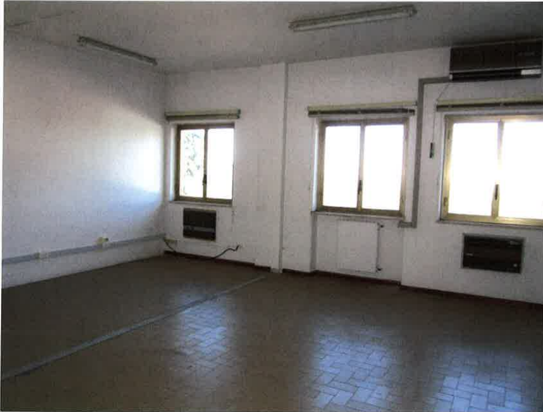
Foto 25: un altro degli ambienti al primo piano del capannone ubicato ad ovest del complesso, già adibiti a spogliatoi e servizi, oggi dismessi
