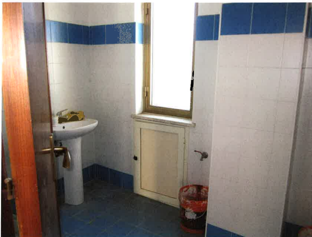
Foto 31: un servizio al primo piano del capannone ubicato ad ovest del complesso, oggi dismesso e non utilizzato
