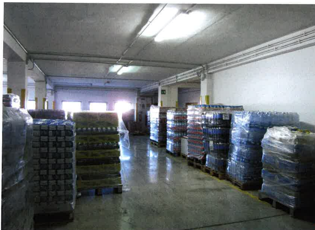
Foto 20: altra panoramica interna della porzione del capannone ubicato ad ovest del complesso immobiliare a destinazione commerciale/logistica, sottostante i locali già adibiti a spogliatoi e servizi, oggi dismessi
