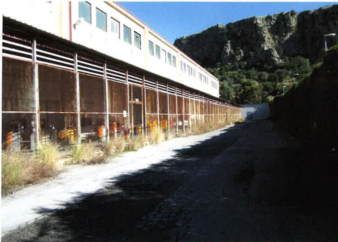
Foto 36: il prospetto sud del capannone ubicato ad est del complesso, lungo il quale si sviluppa la tettoia che ospita le alimentazioni per la ricarica dei carrelli; preciso che ho previsto la rimozione di tale tettoia, in quanto realizzata in assenza di atti autorizzativi ed inclusa tra i manufatti oggetto delle istanze di concessione in sanatoria denegate
