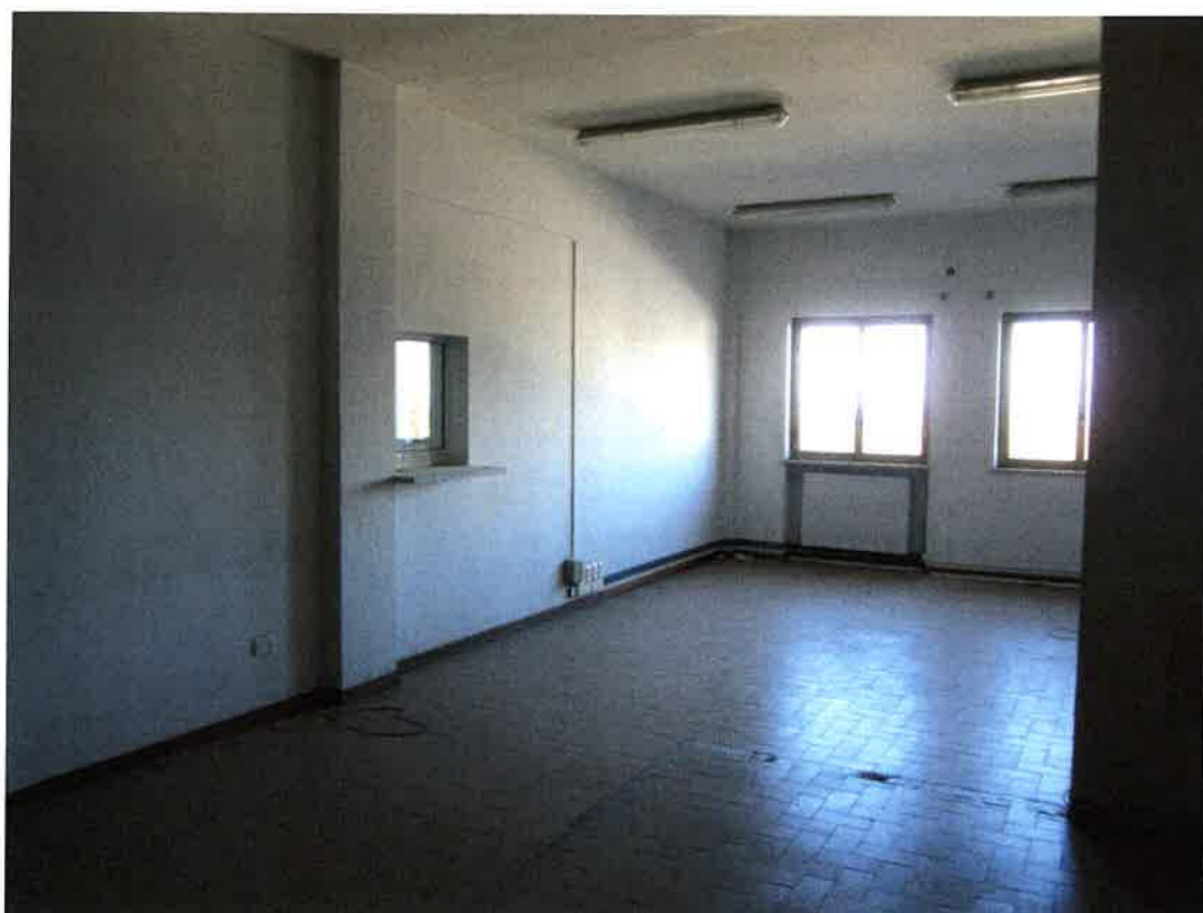
Foto 24: uno degli ambienti al primo piano del capannone ubicato ad ovest del complesso, già adibiti a spogliatoi e servizi, oggi dismessi e non utilizzati
