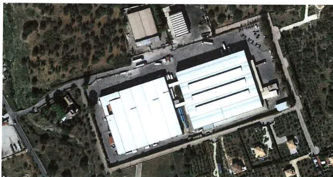
Foto 2: vista dall'alto del complesso immobiliare a destinazione commerciale/logistica, in C.da Case Troia, cui si accede dalla via A. Da Messina, identificato, nel foglio 5, dalle particelle 894 sub. 4-5-6, costituito da due capannoni (uno lato est ed uno lato ovest), collegati da due tunnel, oltre ad alcuni manufatti di servizio, per parte dei quali ho previsto la demolizione, stante l'assenza degli atti autorizzativi
