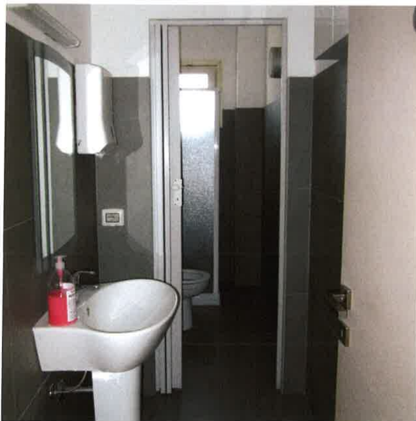
Foto 7: uno dei w.c., con anti-bagno e doccia, a servizio degli uffici ubicati al primo piano del capannone ad est
