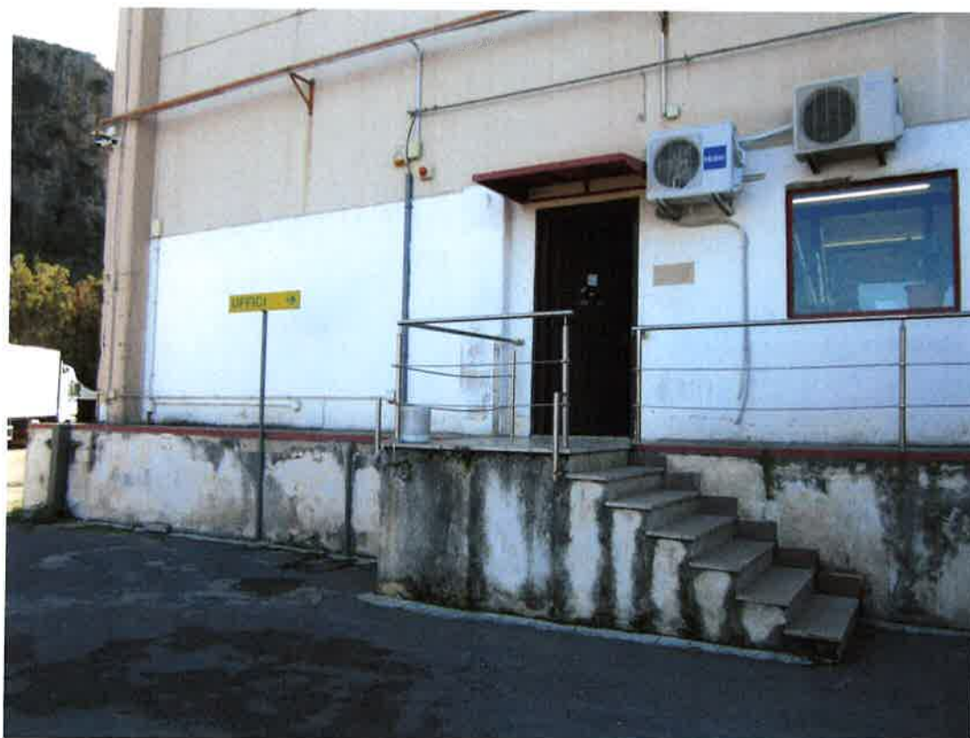
Foto 5: la scala da cui si raggiungono gli uffici a servizio del complesso immobiliare a destinazione commerciale/logistica, ubicati al piano terra e primo del capannone ad est
