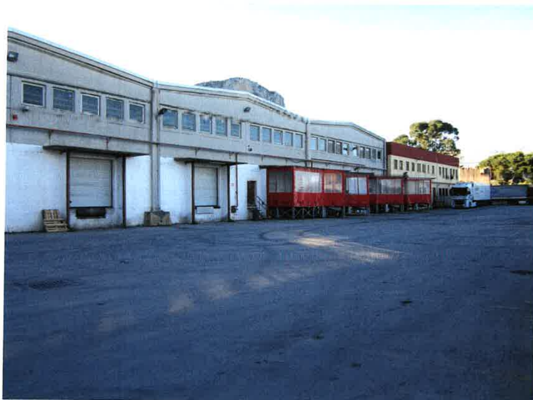
Foto 14: panoramica del capannone ad ovest del complesso immobiliare a destinazione commerciale/logistica, identificato nell'intero, nel foglio 5, dalle particelle 894 sub. 4-5-6
