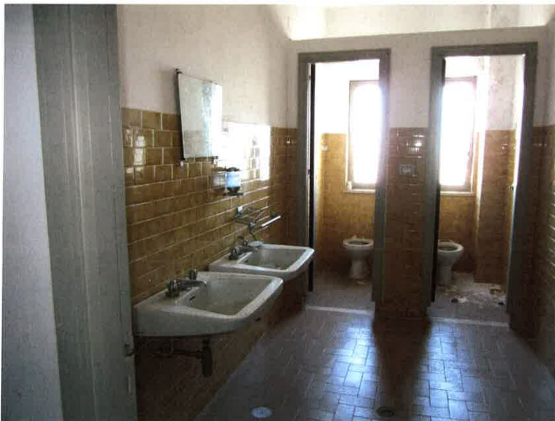
Foto 27: uno dei servizi al primo piano del capannone ubicato ad ovest del complesso, oggi non utilizzato
