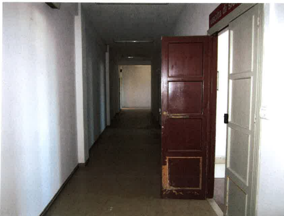
Foto 23: il corridoio che distribuisce i locali al primo piano del capannone ubicato ad ovest del complesso, già adibiti a spogliatoi e servizi, oggi dismessi
