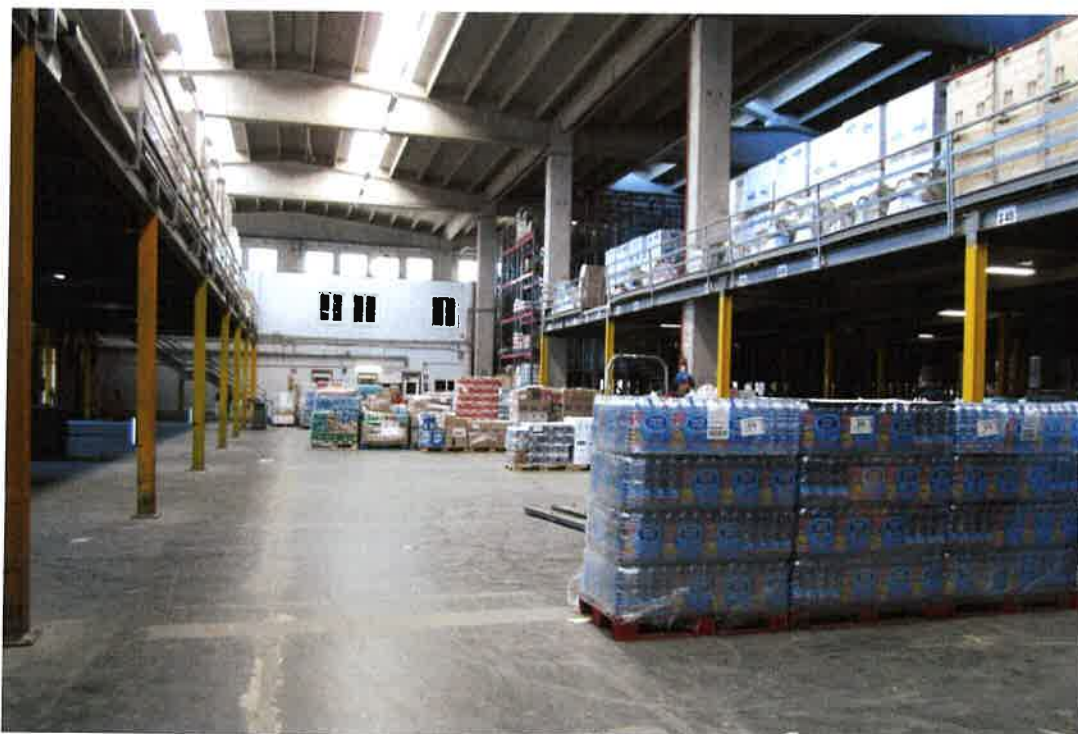
Foto 9: altra panoramica interna del capannone ubicato ad est del complesso immobiliare a destinazione commerciale/logistica; perimetralmente al corridoio centrale due delle strutture metalliche con le quali sono state realizzate ampie zone soppalcate con strutture i cui montanti sono imbullonati a pavimento e, pertanto, facilmente rimuovibili senza che siano necessari interventi di demolizione
