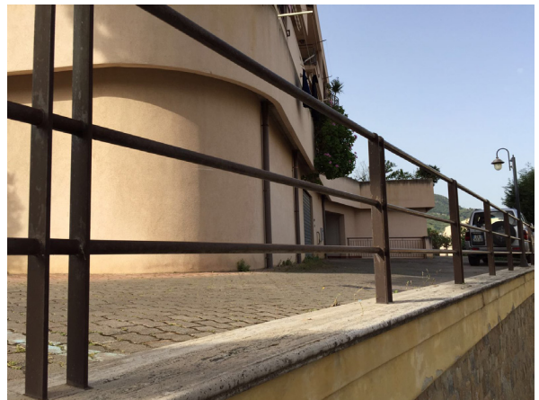
Foto n. 4 - Vista dell'ingresso del lotto B
