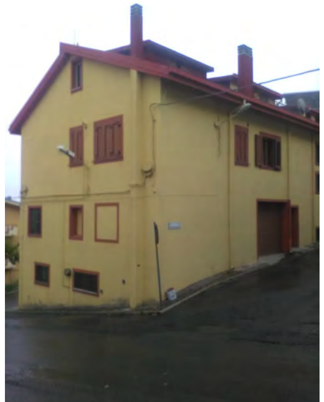
FOTO 2 : PROSPETTO EDIFICIO SU VIA N. PAGANINI
