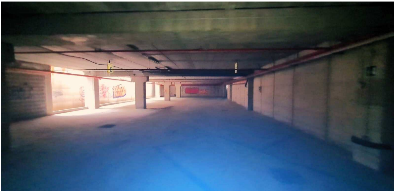
Figura 17 – Vista generale del piano S2 (sulla destra il sub 39, sulla sinistra ed in fondo il sub 40, al centro il sub 12)
