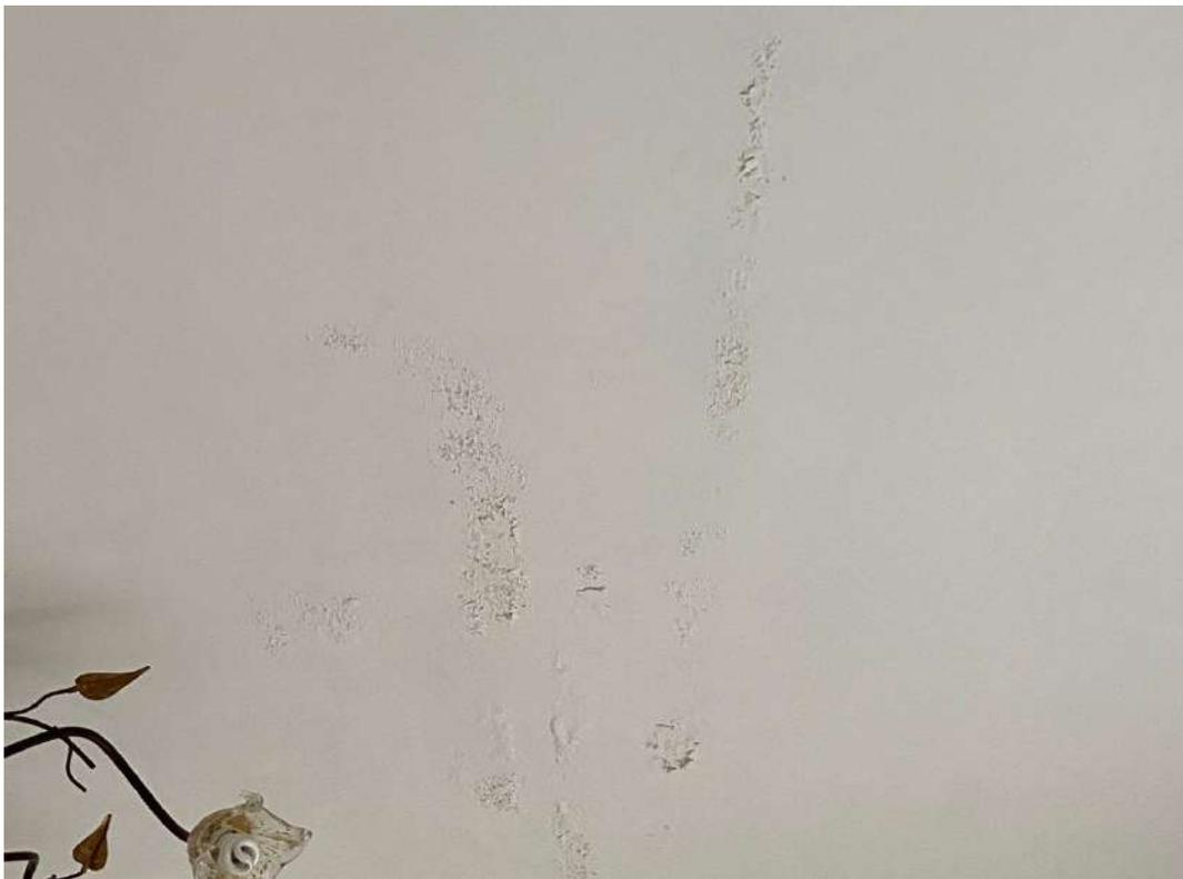
FOTO N. 14– Particolare infiltrazioni piano terra
