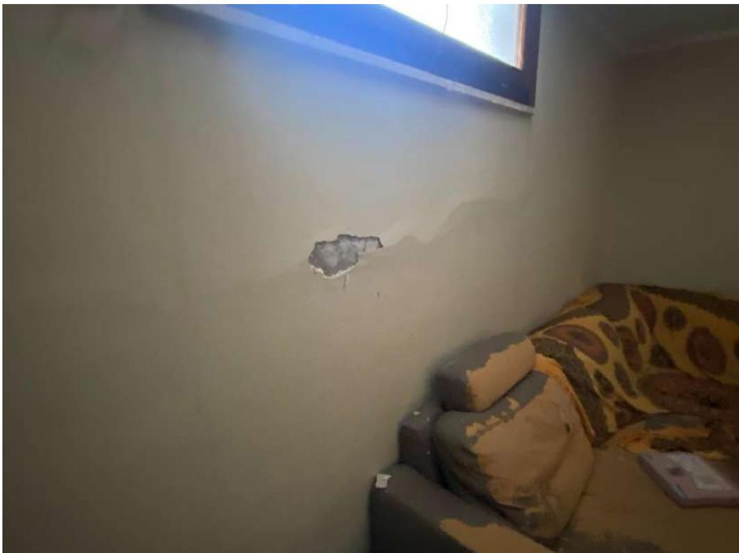
FOTO N. 10- Particolare infiltrazioni piano interrato
