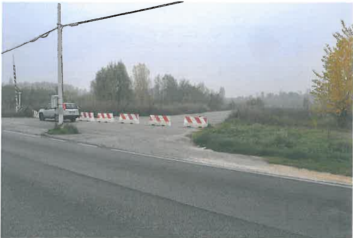
FOTO 1 – VISTA INGRESSO LOTTIZZAZIONE DA S.P. 5 – VIA SAVONAROLA
