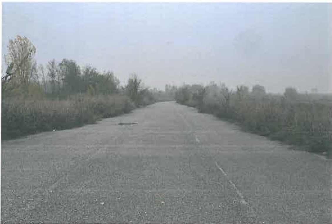
FOTO 2 – VISTA STRADA DI LOTTIZZAZIONE
