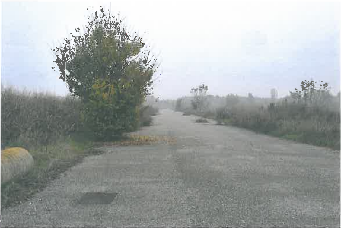
FOTO 5 - VISTA STRADA DI LOTTIZZAZIONE
