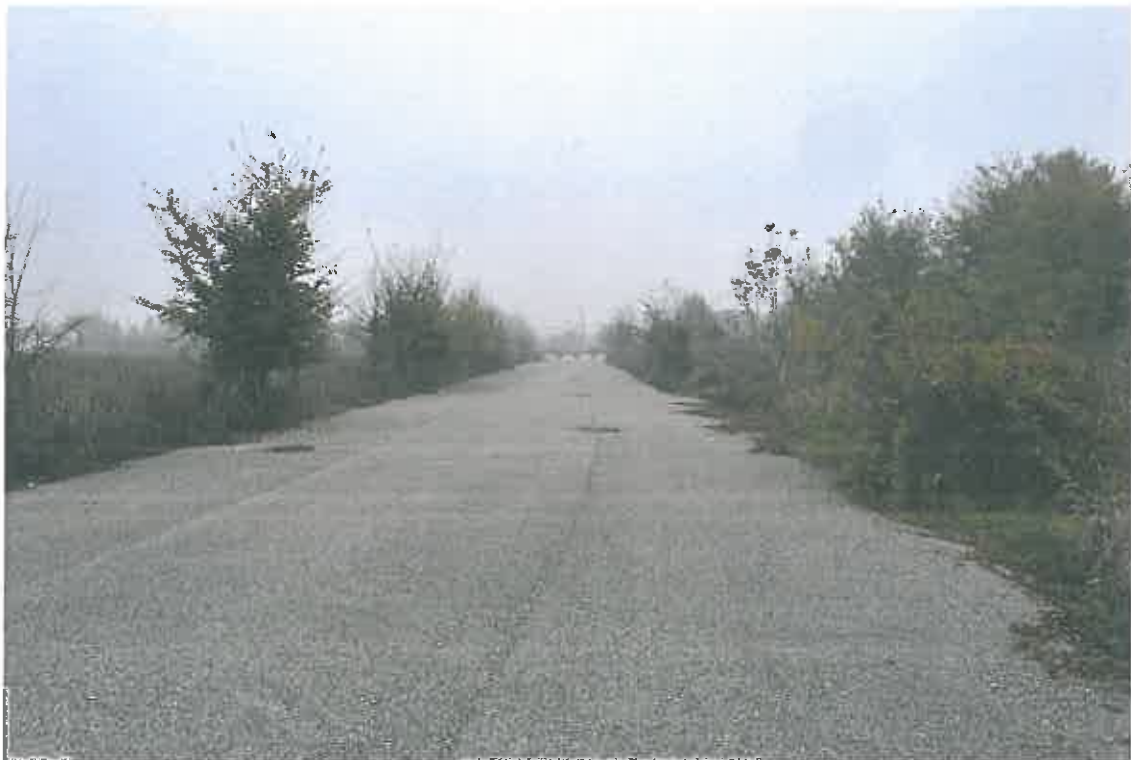
FOTO 6 - VISTA STRADA DI LOTTIZZAZIONE
