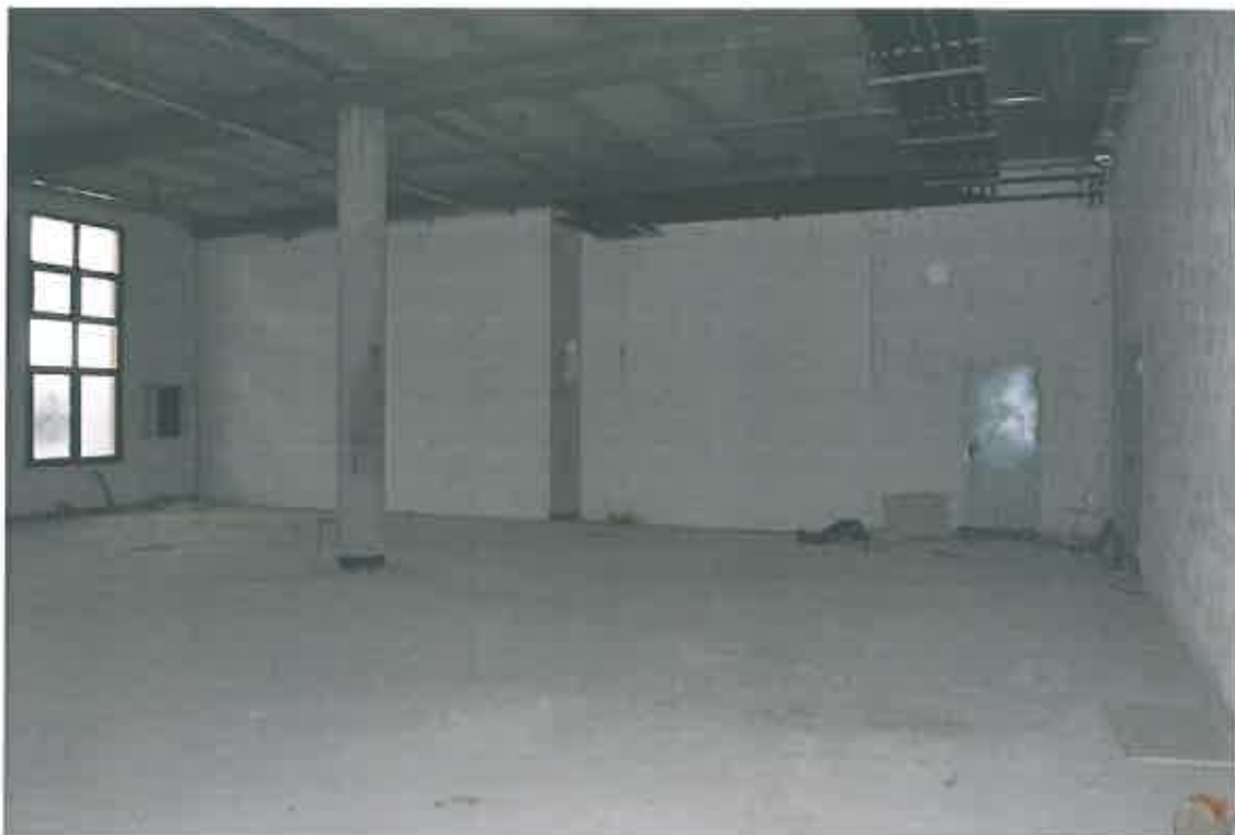
VISTA UNITA' MAGAZZINO SUB 26 PIANO TERRA
