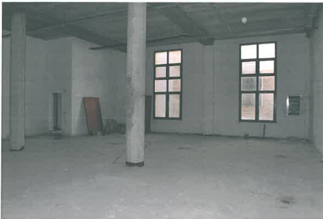
VISTA UNITA' MAGAZZINO SUB 26 PIANO TERRA
