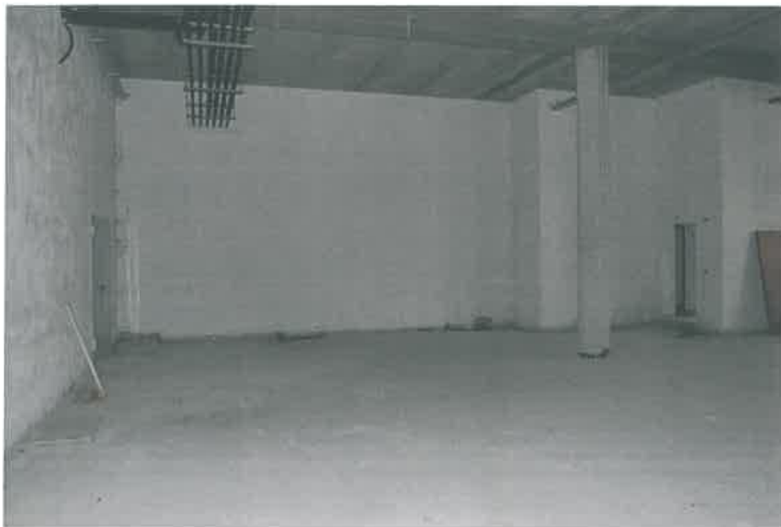
VISTA UNITA' MAGAZZINO SUB 26 PIANO TERRA
