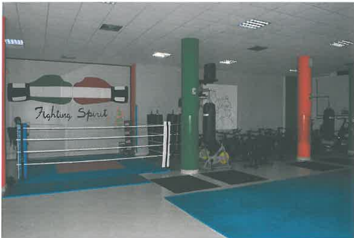
VISTA UNITA' A DESTINAZIONE PALESTRA SUB 27 PIANO TERRA
