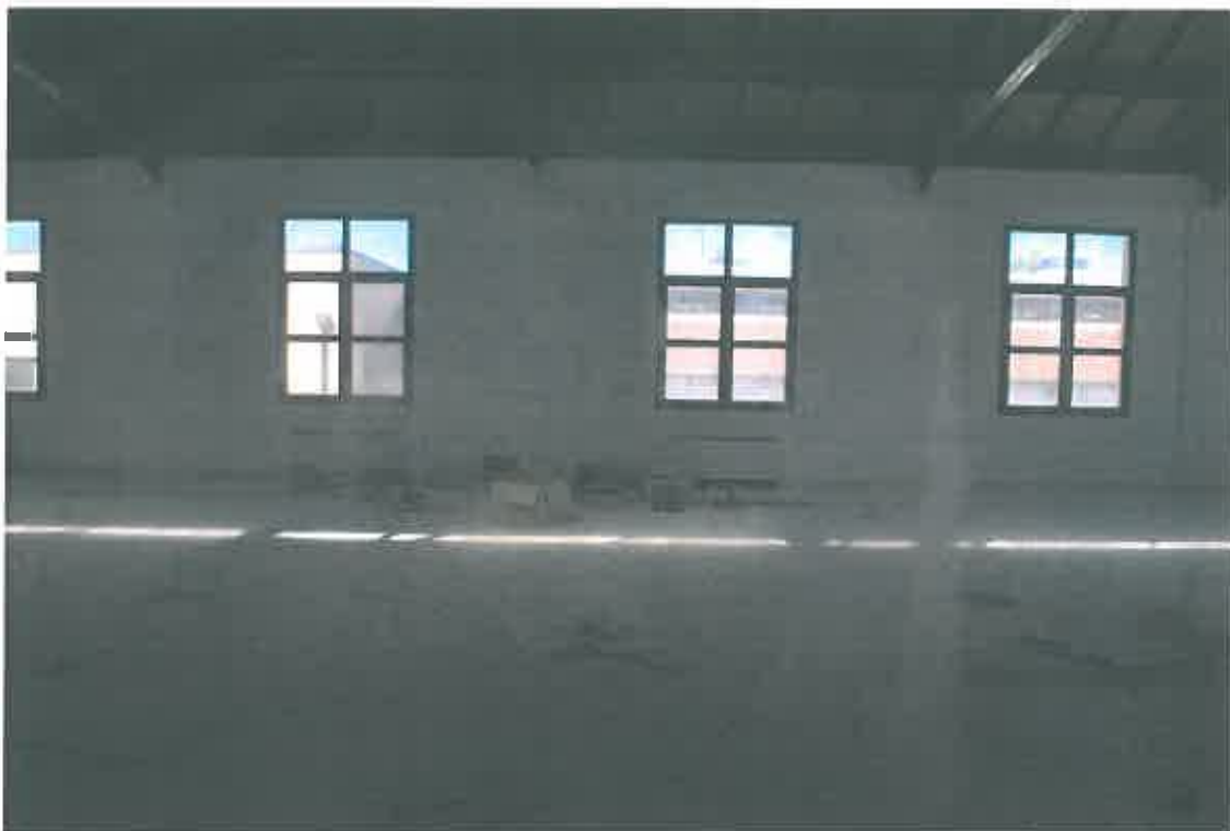
VISTA LOCALE ATTIVITA' DIREZIONALE SUB 9 PIANO SECONDO (INACCESSIBILE)
