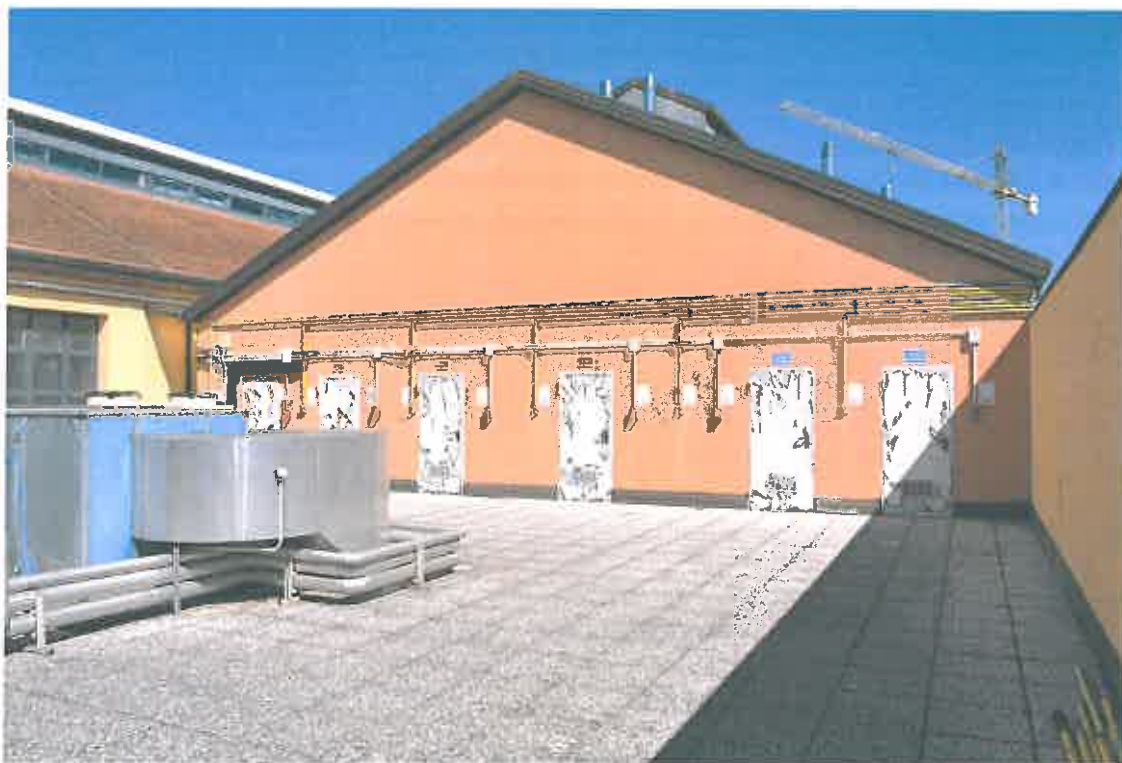
VISTA LOCALI CENTRALI TERMICHE UNITA' DIREZIONALI
