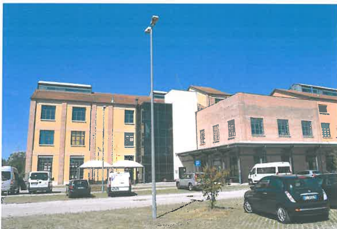
VISTA PROSPETTO EST
