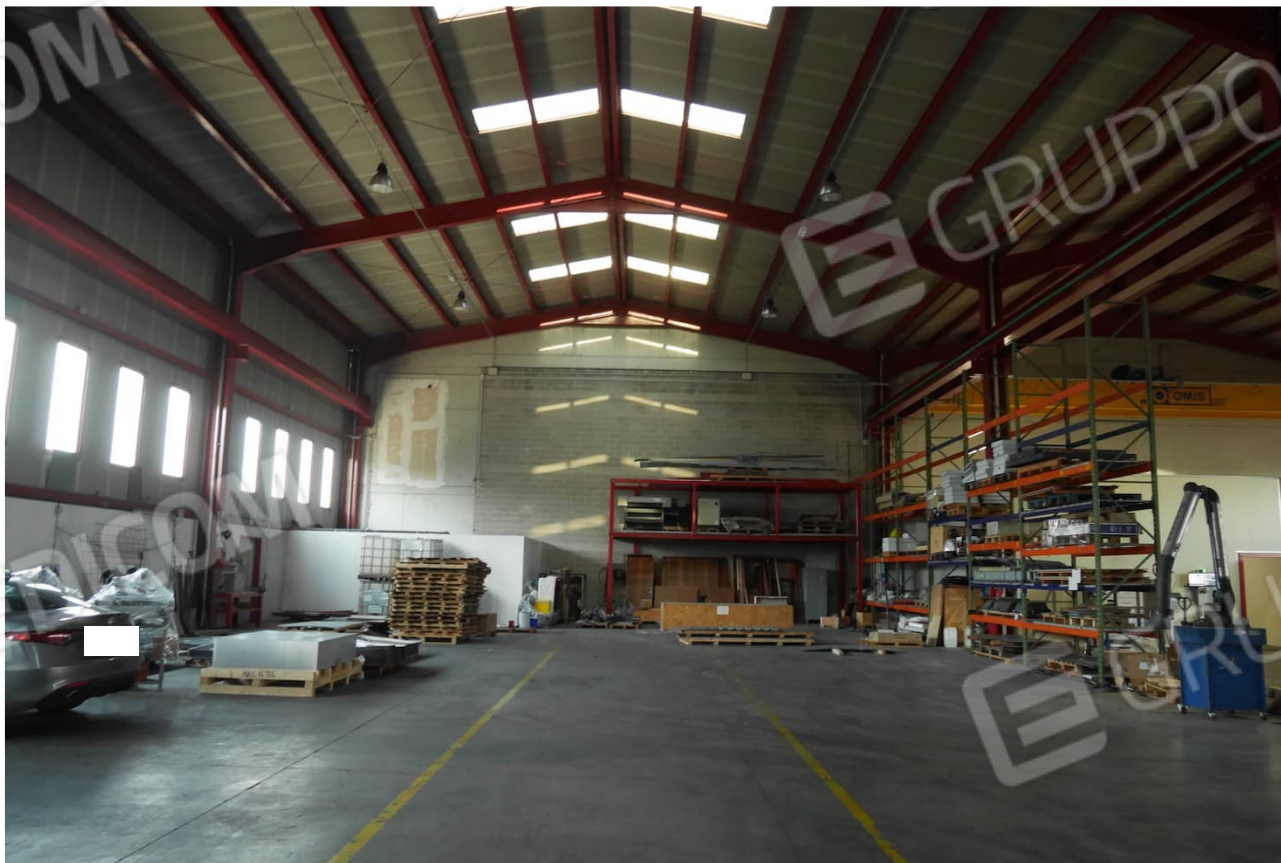
FOTO 14 - Porzione ad uso capannone industriale.
