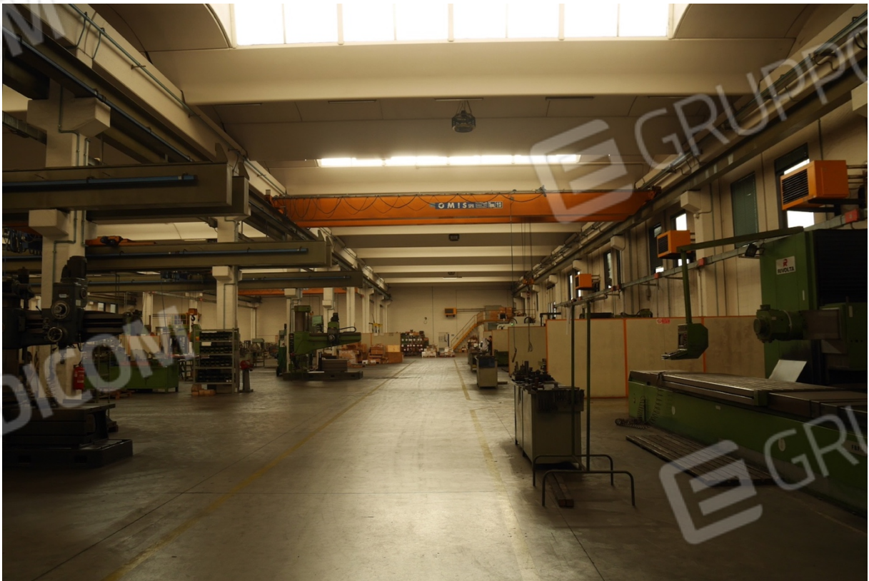
FOTO 4 - La porzione ad uso capannone.
