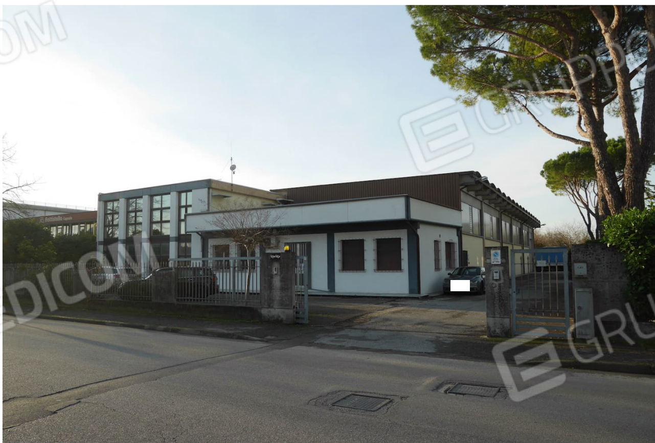
FOTO 10 - Il capannone industriale-laboratorio con relativi uffici di cui al mappale 432. L'accesso principale dalla Via 1° maggio.
