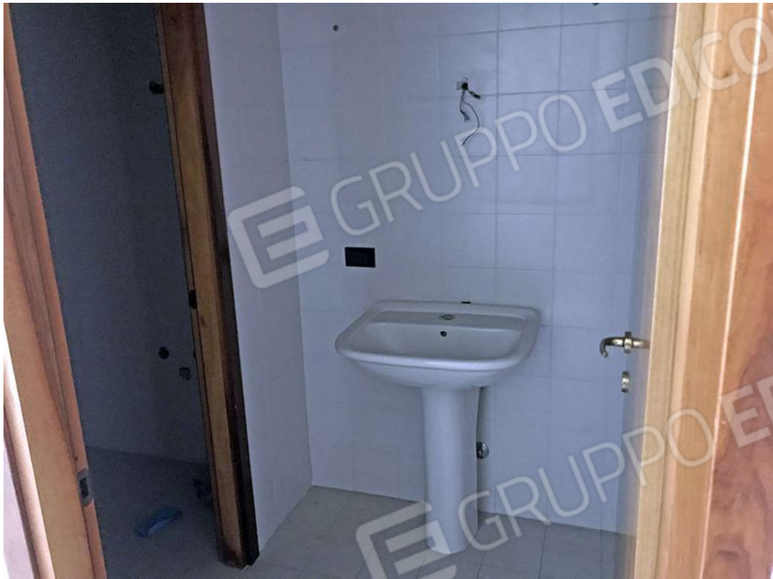
L'antibagno dell'ufficio sub61.
