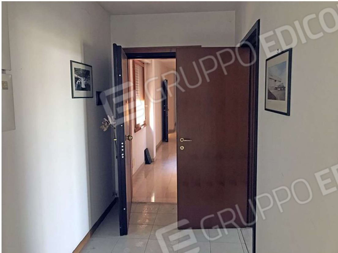
L'ufficio sub61 con la porta di ingresso e di connessione con l'ufficio sub60.
