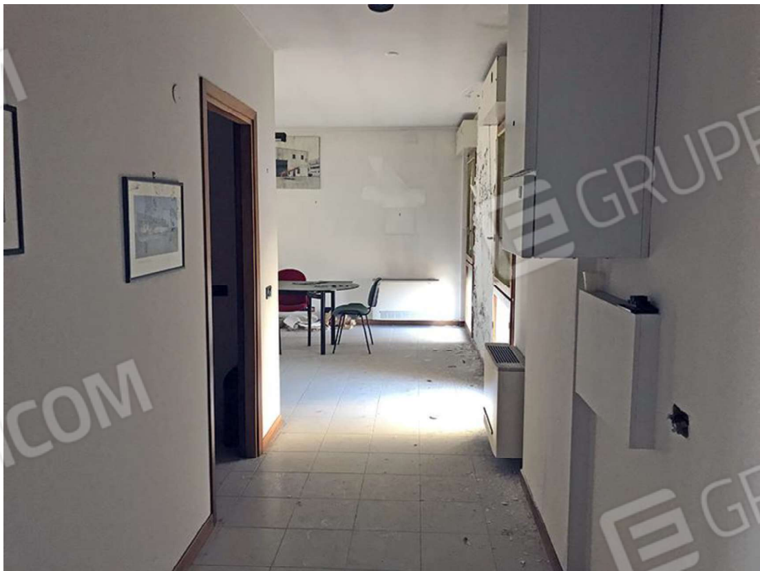
L'ufficio sub61 con il corridoio di ingresso e la caldaia interna.
