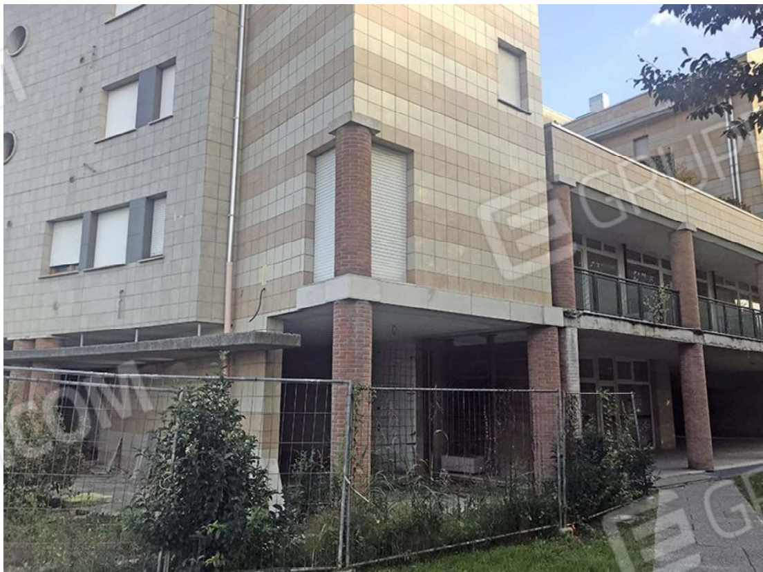
La parte adiacente all'angolo di edificio mai ultimata.
