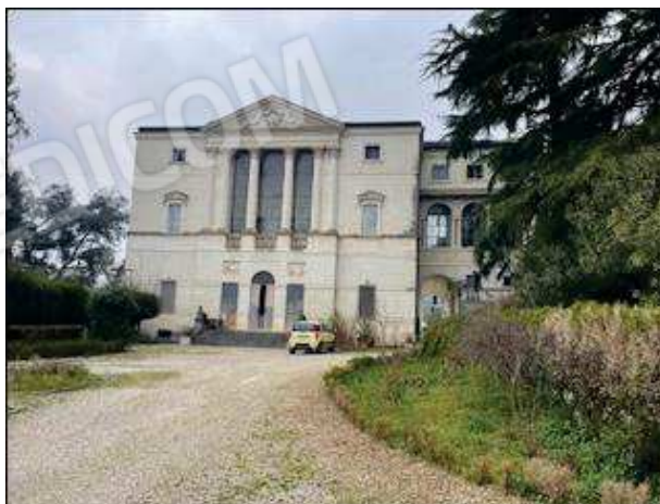
Corpo di fabbrica "E"
