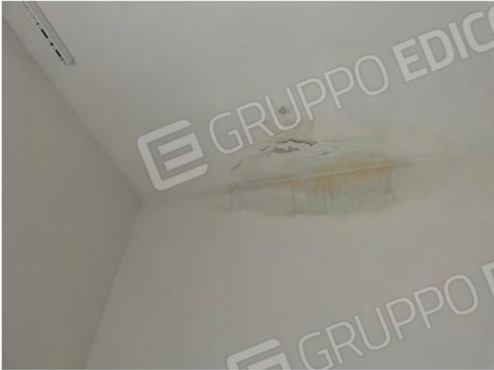
Fotografia F.5 - Macchia di umidità a soffitto camera lato est
