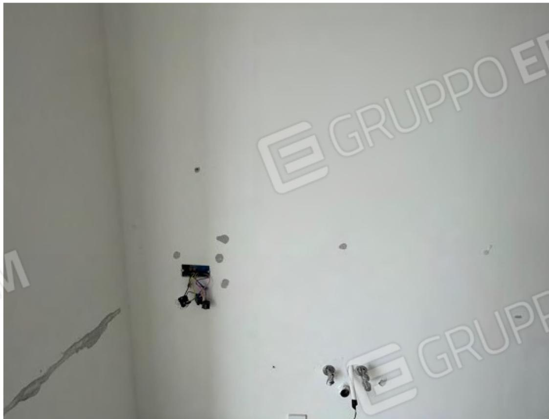
Fotografia F.15 - Parete per mobili componibili e ripiano cucina, a vista, con i segni visibili di un intervento di rimozione del mobilio e segni dei precedenti fissaggi, non ripristinati
