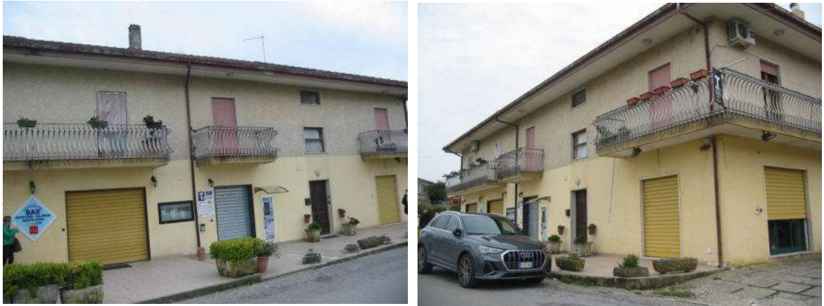
Foto 60-61 – Particolare della corte esterna aggraffata alla part.lla 410, consistente nel marciapiede antistante la Via Cristoforo Colombo.
