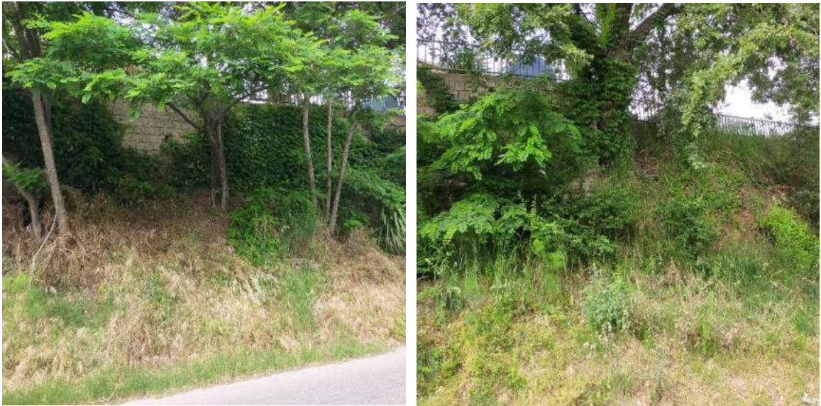
Foto 64-65 – Particolare del muro in blocchi presente sul confine Sud della corte del fabbricato.
