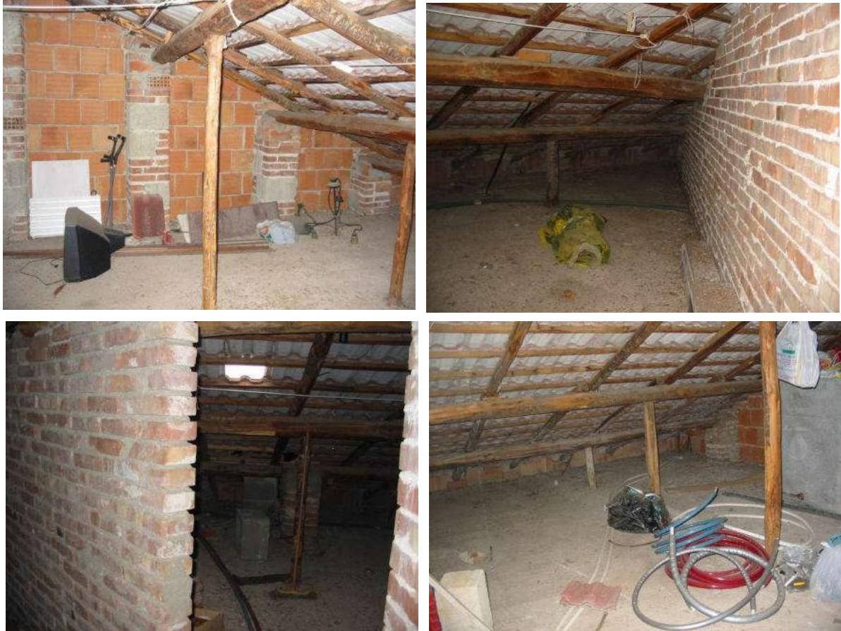
Foto da 23 a 26 - Particolare del sottotetto praticabile ma non abitabile, accessibile dal vano scale.
