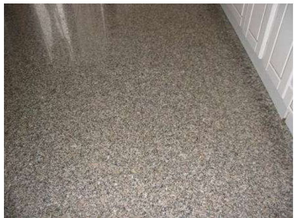
Foto 27-28-29 - Corridoio di ingresso e vano cucina. Particolare della pavimentazione della zona giorno a tappeto unico in granito.
