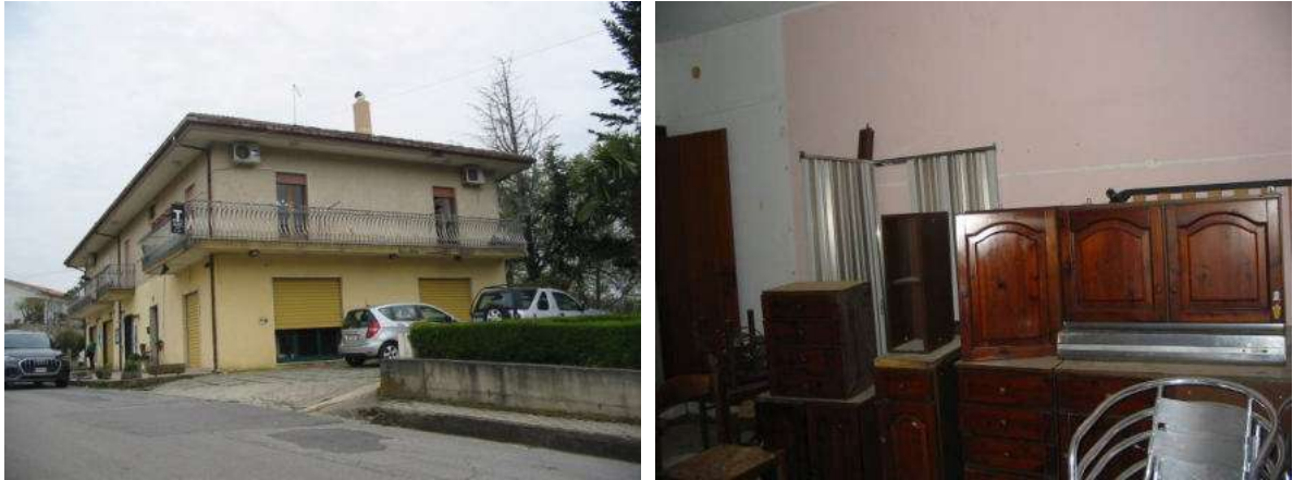
Foto 56-57 - Porte di accesso esterne al locale. Particolare del vano principale fronte strada.
