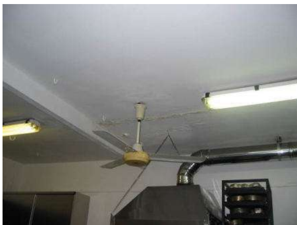
Foto 42-43 – Locale sul retro adibito a cucina industriale. Particolare dell'estradosso del lastrico solare superiore da cui risultano i segni di infiltrazioni di acqua. La foto a destra è relativa al piccolo ripostiglio ricavato a fianco del bagno.
