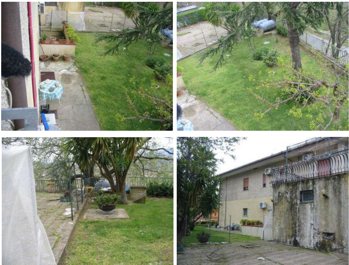
Foto 66-67-68-69 – Particolare del terreno circostante il fabbricato (part. lle 672 ad Ovest e Sud-Ovest e 671 ad Est e Sud-est), in parte a verde e in parte pavimentata.
