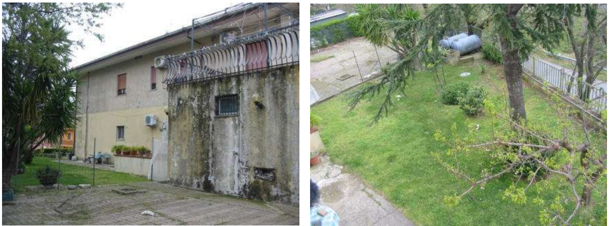
Foto 7-8 - Facciata Sud del fabbricato. L'area esterna che circonda su tre lati il fabbricato, a verde e a parcheggio, è censita alla part.Illa 672 (area Ovest e Sud-Ovest) e alla part.Illa 671 (area Est e Sud-Est).
