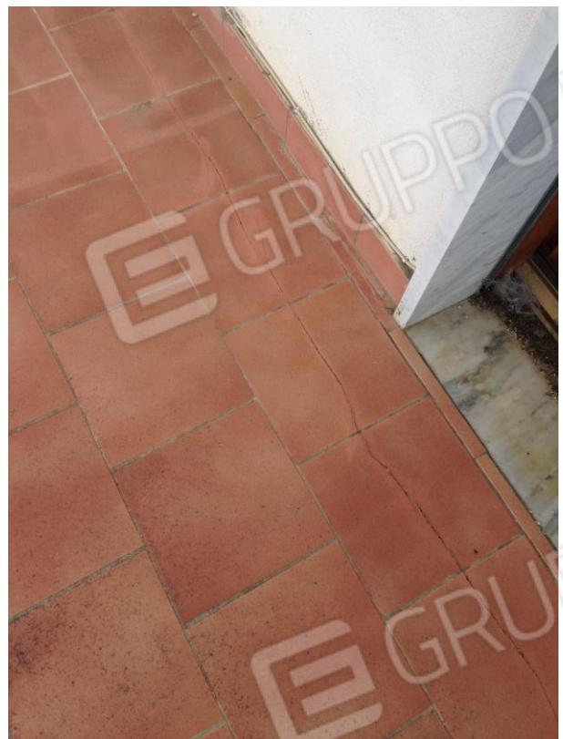
Foto 19 e 20: balcone esterno da cui si ravvisano evidenti fenomeni di deterioramento della pavimentazione
