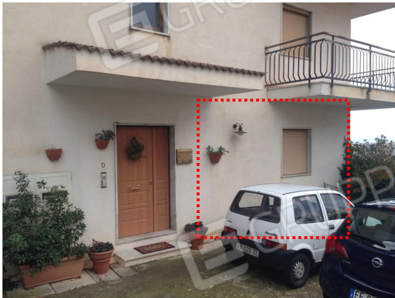
Foto 1: ingresso dal piazzale esterno
