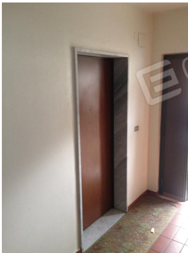
Foto 4: portoncino d'ingresso dal vano scala interno
