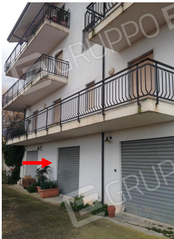
Foto 21: facciata lato N
