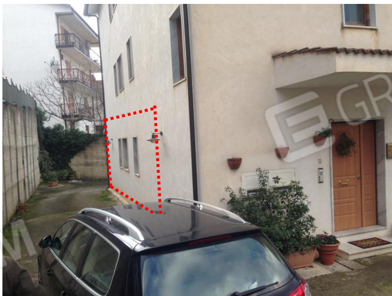
Foto 2: ingresso dal piazzale esterno
