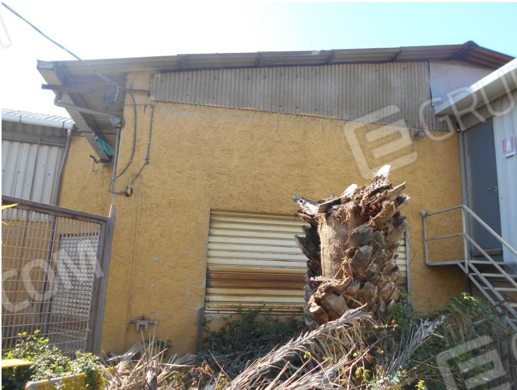
Foto n. 4: prospettiva opificio oggetto di accertamento – da notare l'ingresso al disimpegno dei vani adibiti ad uffici.
