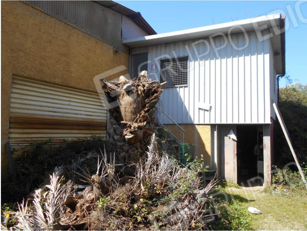
Foto n. 5: prospettiva opificio oggetto di accertamento – prospettiva ingresso deposito “dep1”.
