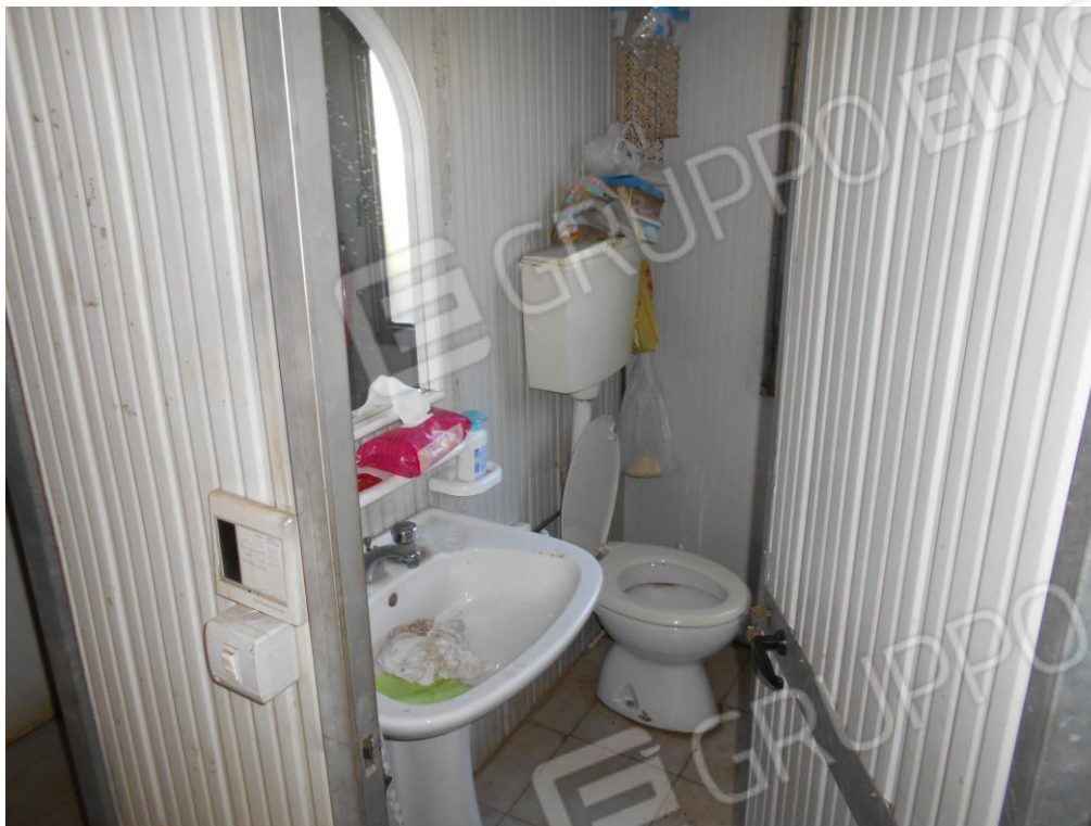
Foto n. 27: prospettiva bagno “wc2”.
