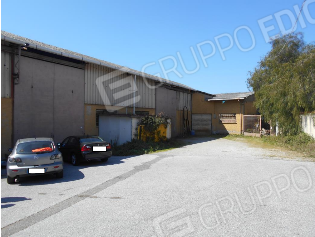
Foto n. 1: prospettiva opificio oggetto di accertamento.
