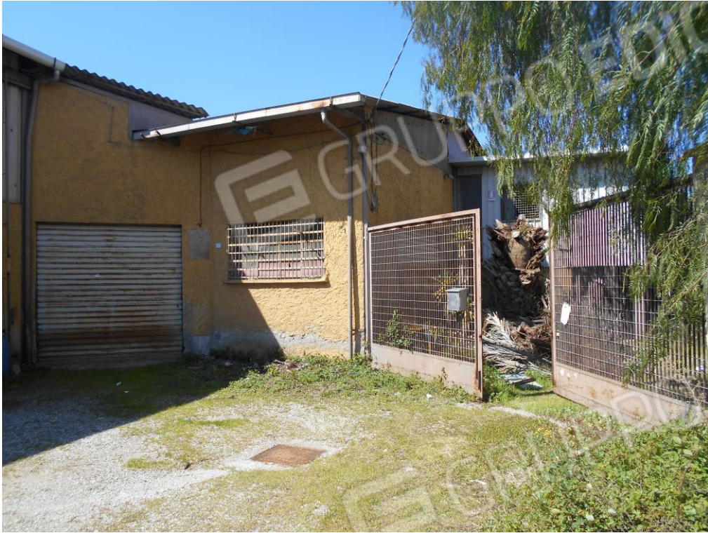
Foto n. 3: prospettiva opificio oggetto di accertamento.
