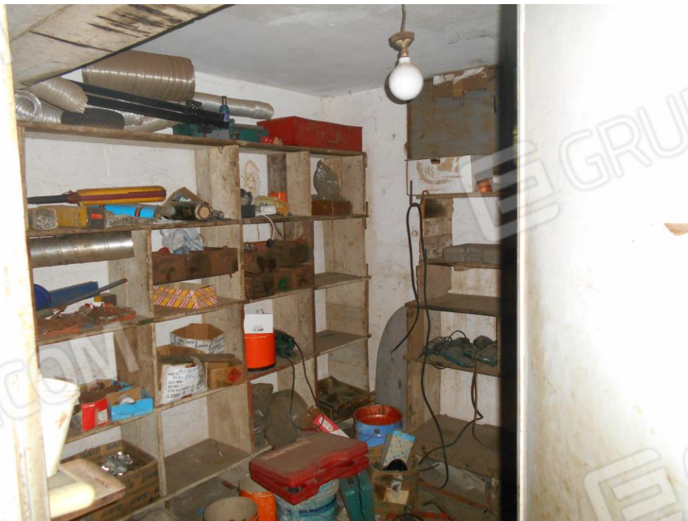
Foto n. 18: prospettiva deposito “dep2”.
