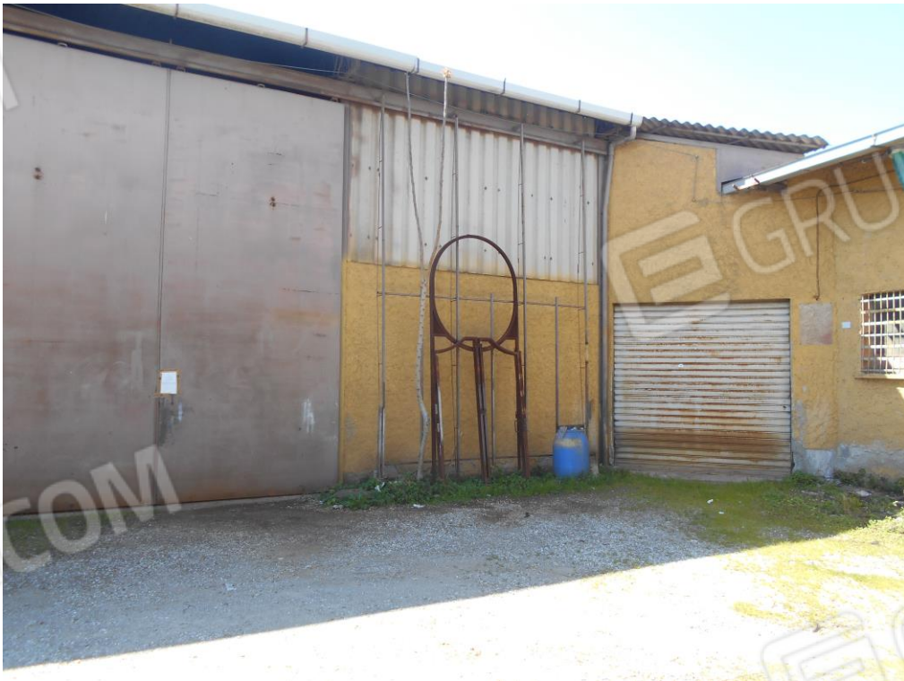
Foto n. 2: prospettiva opificio oggetto di accertamento.
