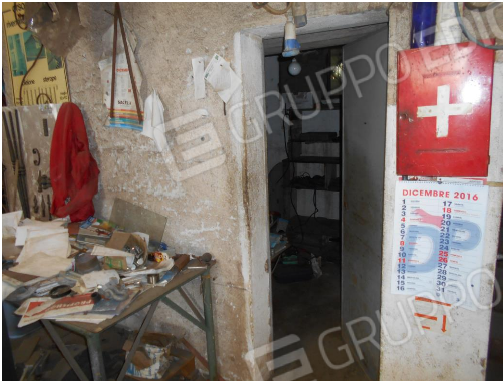
Foto n. 17: prospettiva deposito “dep2” – particolare ingresso.
