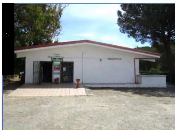
Vista Laterale del blocco C6- D1
