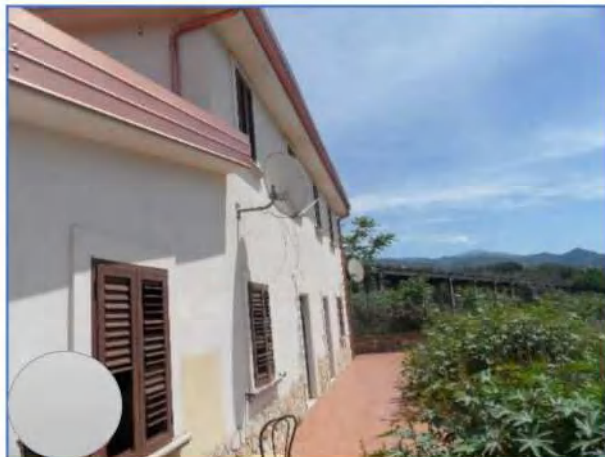
Blocco A1 – Vista esterna del retro
