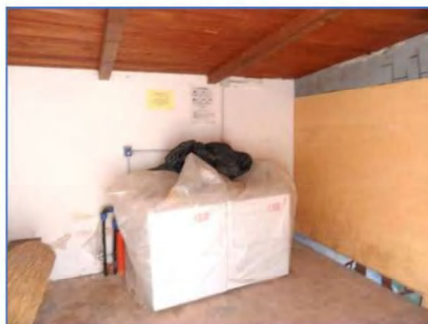
N4 – Interno dei locali lavanderia
