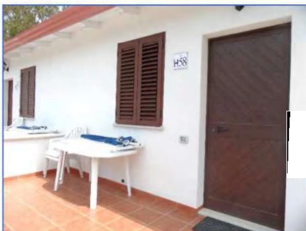
C6 – vista degli accessi agli alloggi
