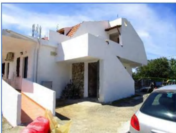
Blocco C9 - Scala esterna in cemento armato per raggiungere il primo piano
