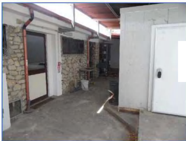
Esterno del Ristorante – Retro della cucina, particolare della cella esterna.
