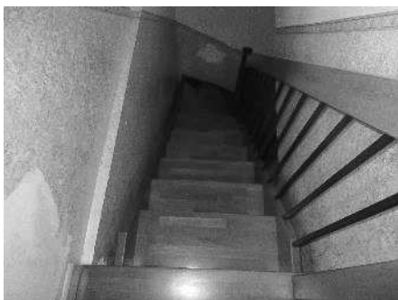
Foto n. 28 – Scala di accesso
