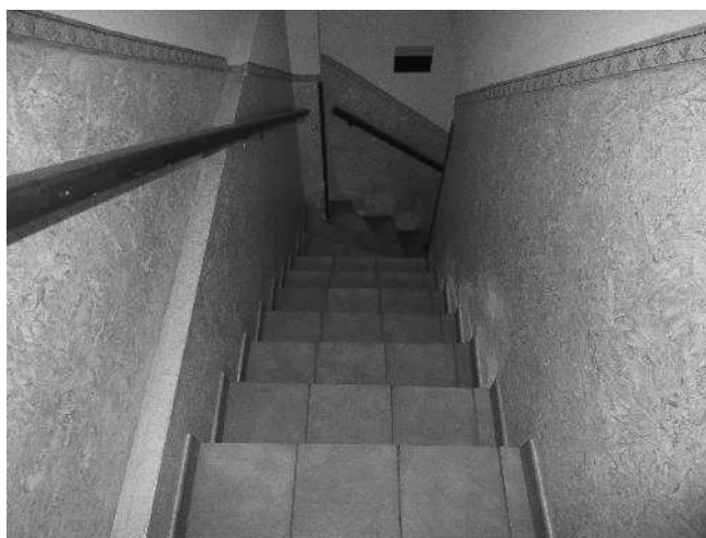
Foto n. 23 – Scala di collegamento tra piano terra e piano primo
