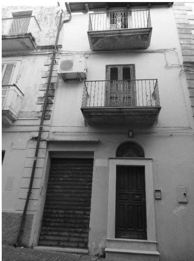
Foto n. 22 – Prospetto su via F. Fiorentino
