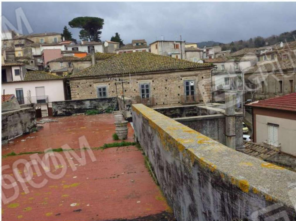
**Foto n. 154:** Copertura piana dalla quale provengono le infiltrazioni di acqua meteorica riscontrate al primo piano (secondo fuori terra) dell'immobile sito nel comune di Maida (lotto n. 6).
