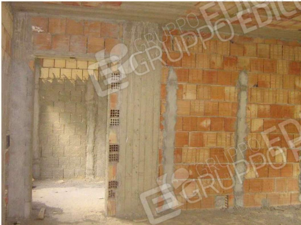
Foto n. 25: particolare tamponature di separazione dei vani del primo piano - Fabbricato "A"
