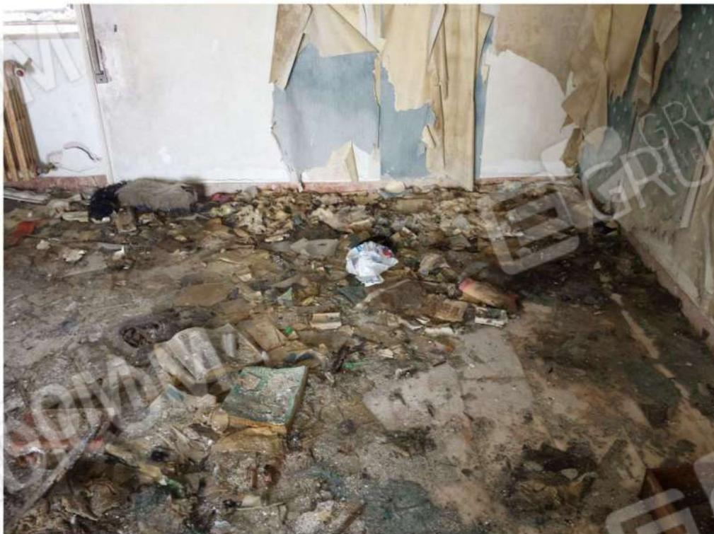
**Foto n. 150:** Materiale vario (degradato a causa delle infiltrazioni provenienti dalla copertura) depositato al piano primo dell'immobile sito nel comune di Maida (lotto n. 6).
