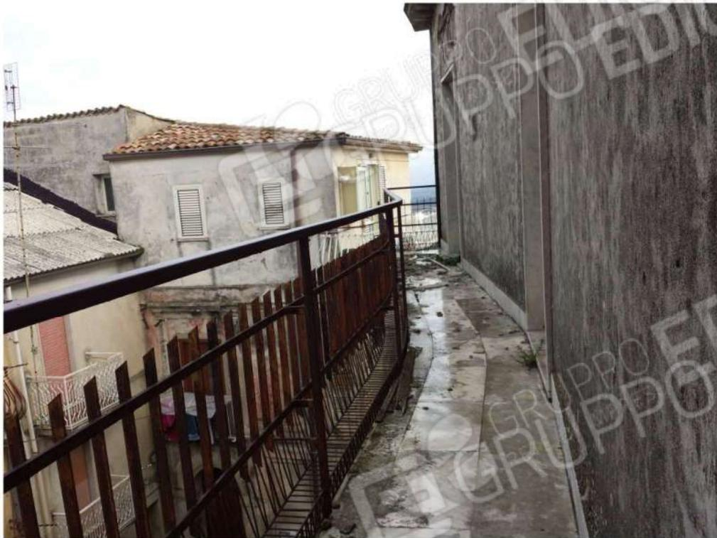
**Foto n. 155:** Balcone ubicato al primo piano (secondo fuori terra) sul prospetto Ovest dell'immobile sito nel comune di Maida (lotto n. 6); si nota la presenza di calcinacci.
