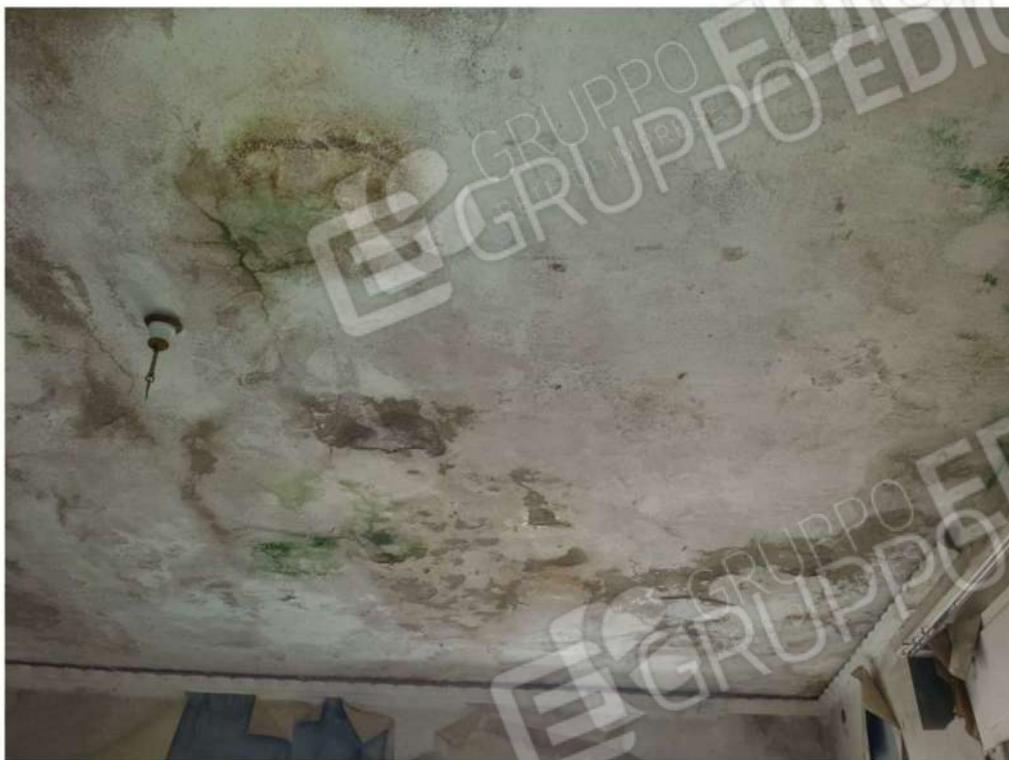
**Foto n. 149:** Macchie d'umidità causate dalle infiltrazioni di acqua meteorica provenienti dalla copertura riscontrate sull'immobile sito in Maida (lotto n. 6).
