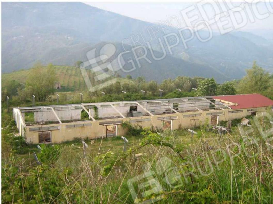
**Foto n. 79:** foto prospettica fabbricato “E” adibito ad allevamento – da notare che la struttura di copertura è stata oggetto di furto (lotto n. 4).
