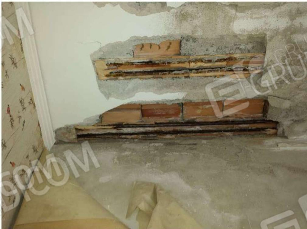
**Foto n. 152:** Danni al solaio causati dalle infiltrazioni di acque meteoriche provenienti dalla copertura dell'immobile sito nel comune di Maida (lotto n. 6).
