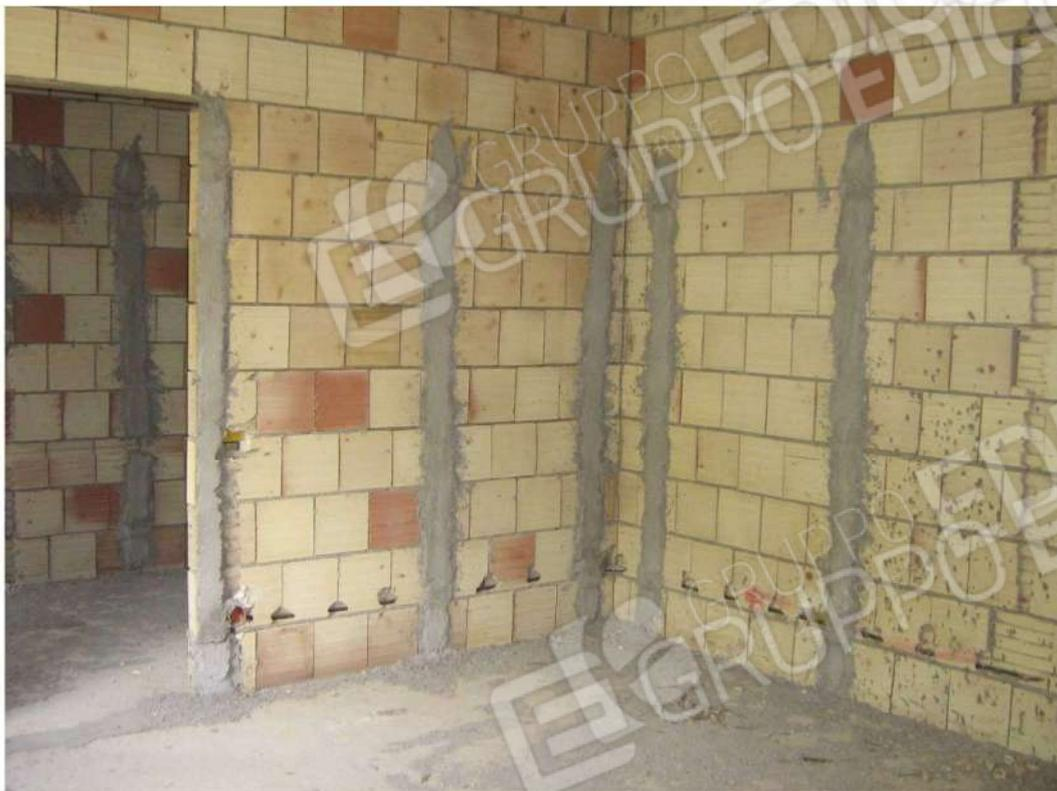
Foto n. 27: particolare delle guide preordinate alle operazioni di intonacatura delle pareti - Fabbricato "A" (lotto n. 4).
