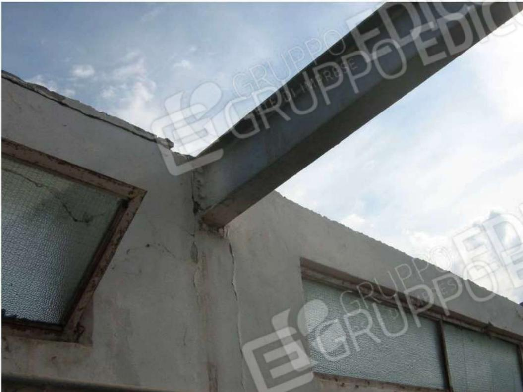
Foto n. 95: particolare travi appoggio trave principale della struttura di copertura sulla parete perimetrale - Fabbricato "E" (lotto n. 4).
