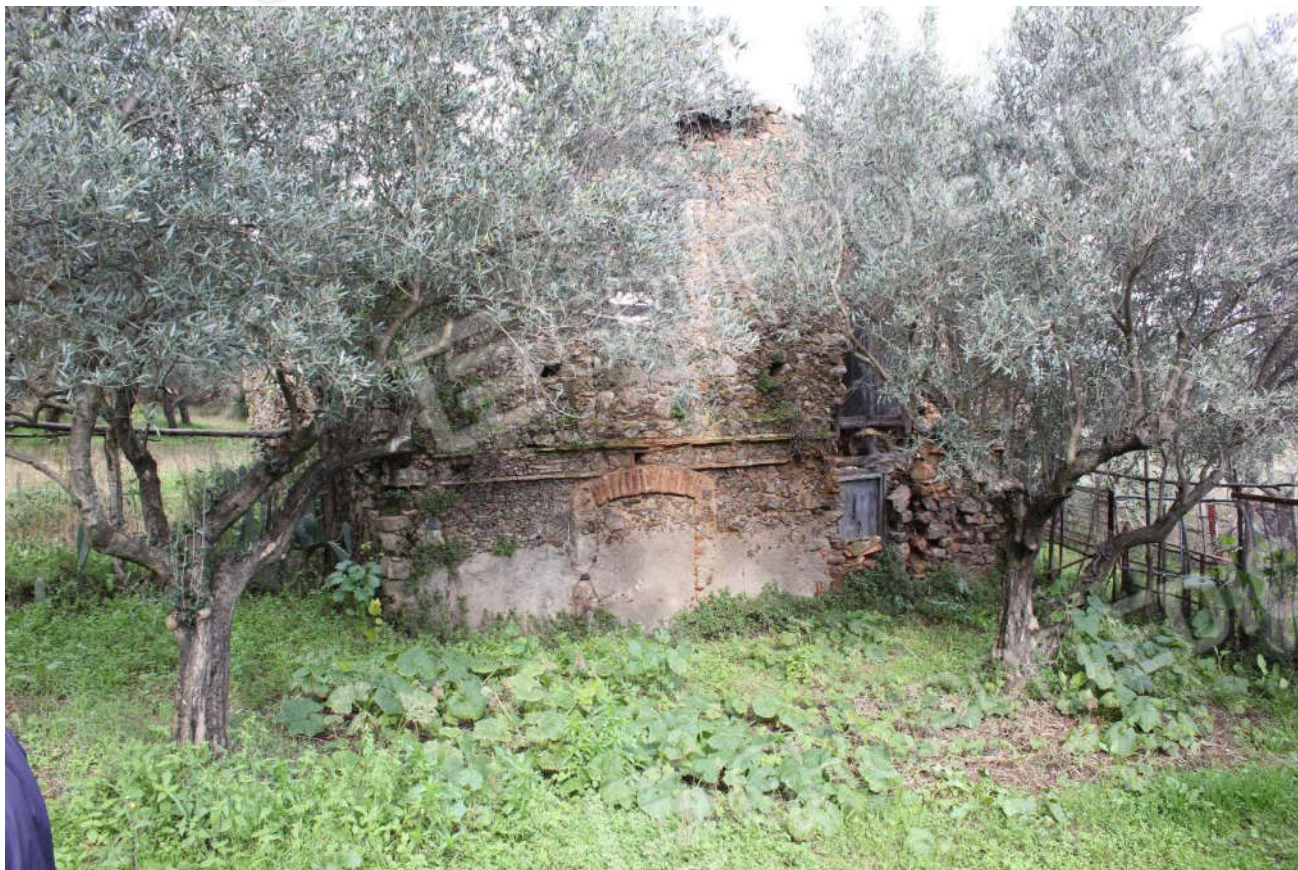
- Foto n° 61 - Comune di Amaroni. Foglio 16, p.lla 11.
