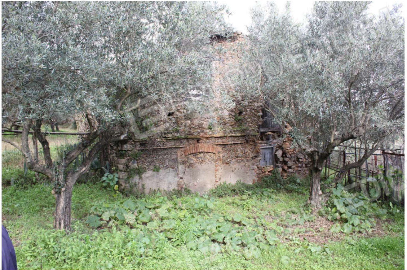
- Foto n° 61 - Comune di Amaroni. Foglio 16, p.lla 11.
