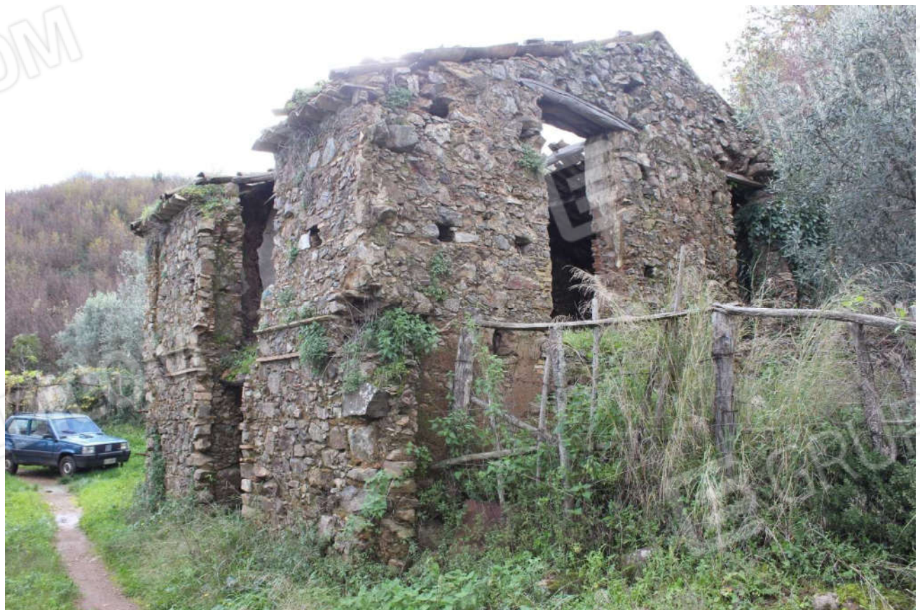
- Foto n° 62 - Comune di Amaroni. Foglio 16, p.lla 11.
