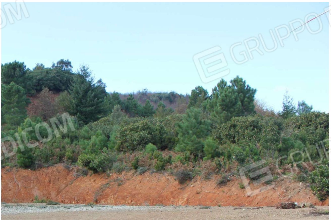
- Foto n° 24 - Comune di Valle Fiorita. Foglio 16, p.lla 45 (porzione sud-ovest, al confine con la p.lla 41).
