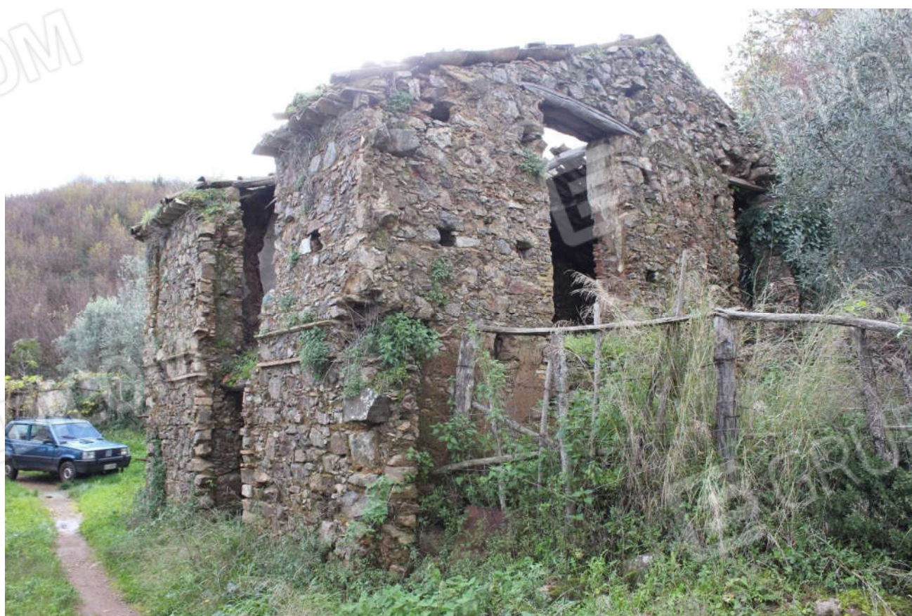
- Foto n° 62 - Comune di Amaroni. Foglio 16, p.lla 11.
