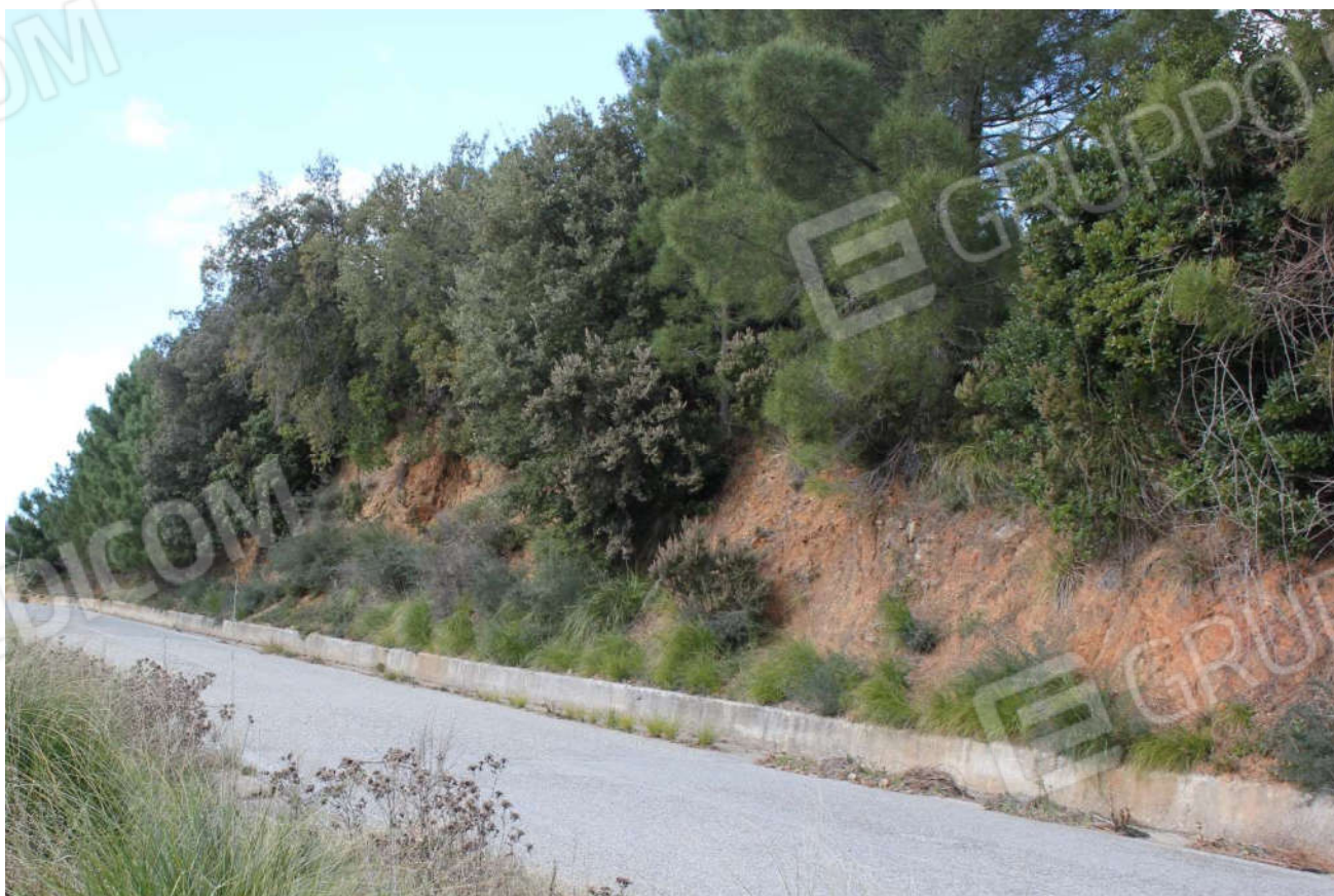
- Foto n° 44 - Comune di Amaroni. Foglio 16, p.lla 45 (porzione sud-est confinante con la strada Comunale Vurdunara).
