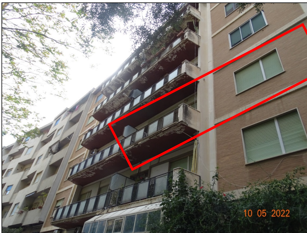
Figura 5: Prospetto esterno del fabbricato (lato Via Santa Lucia al Parco), con individuazione dell'immobile oggetto di perizia
