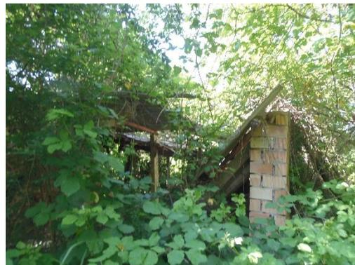
I manufatti hanno una struttura di tipo precario con alcune parti realizzate in lastre di eternit che dovranno essere rimosse e smaltite da ditte specializzate.
