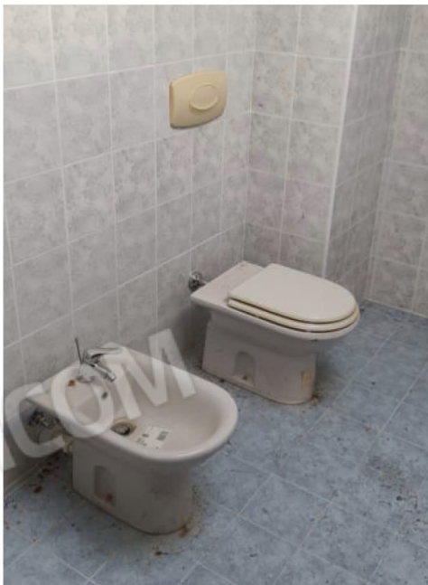
CASTEGGIO- VISTA BAGNO
