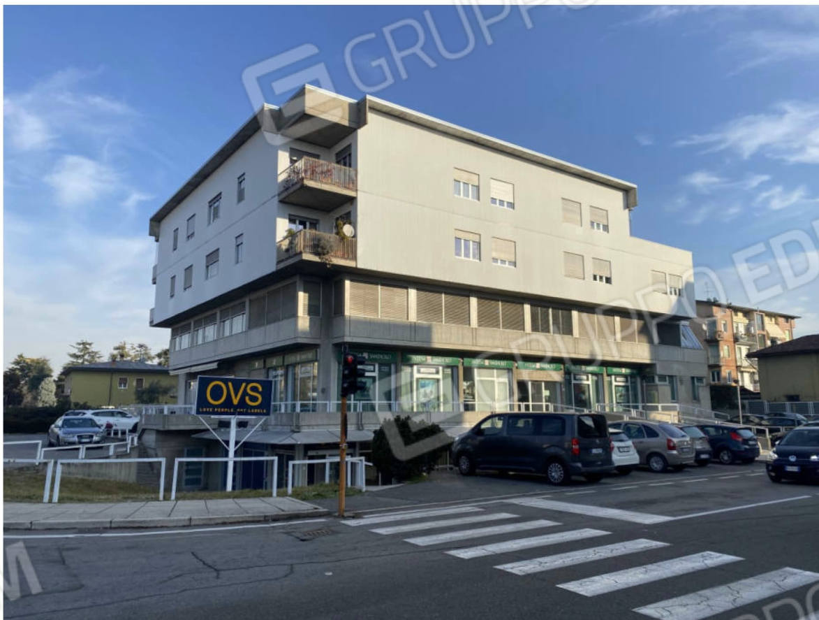
MARTINENGO - VISTA EDIFICIO IN CUI SONO ALLOCATE LE UNITA' IMMOBILIARI
