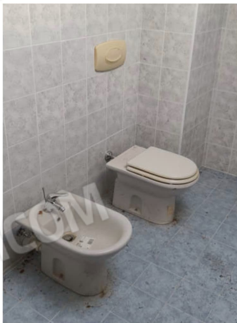
CASTEGGIO- VISTA BAGNO
