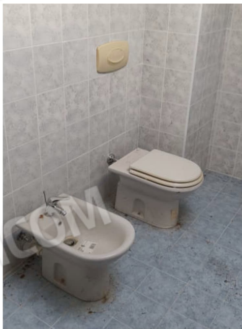
CASTEGGIO- VISTA BAGNO
