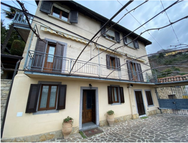
Foto07 vista esterna sub.702-704 -705
