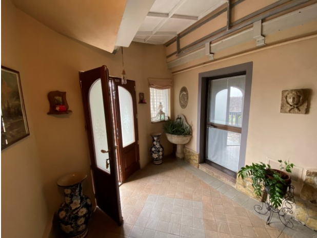
Foto21 P2 porzione accesso a sub.705 non autorizzata
