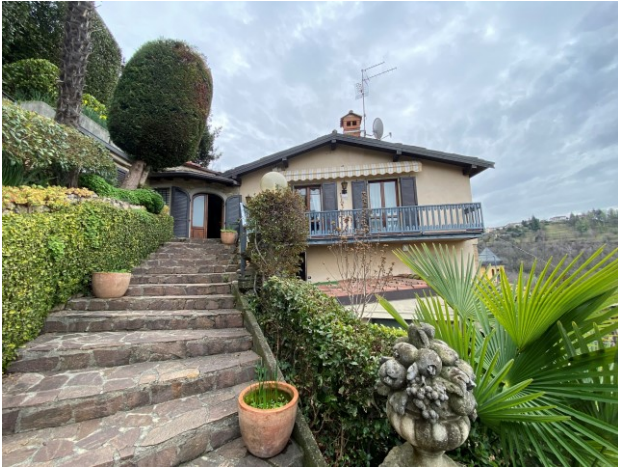
Foto19 vista esterna sub.705
