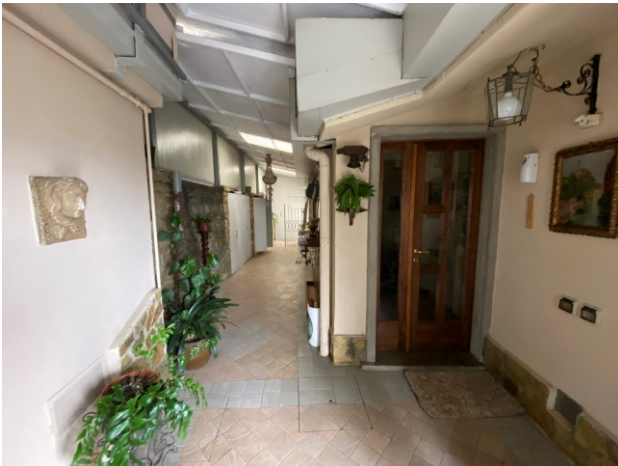
Foto23 P2 ingresso sub.705 e collegamento al vano ascensore non autorizzato
