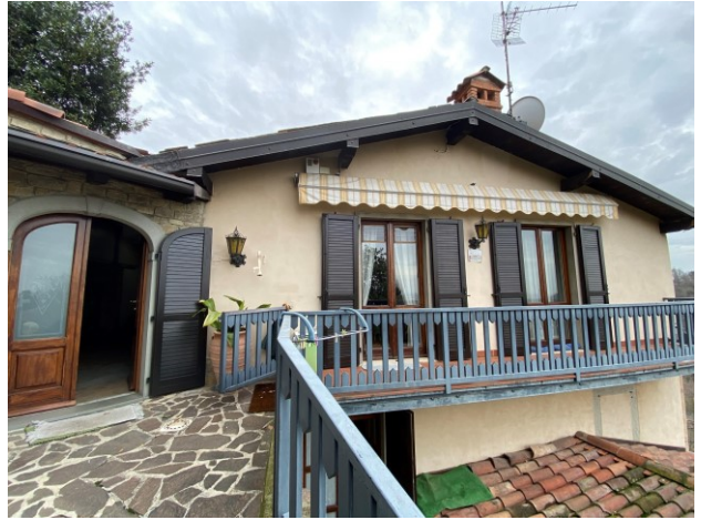
Foto20 vista esterna sub.705
