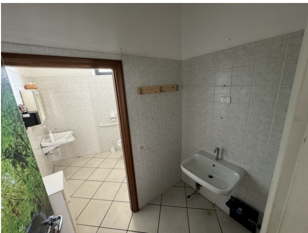
Foto05 vista su antibagno e bagno PT sub.13
