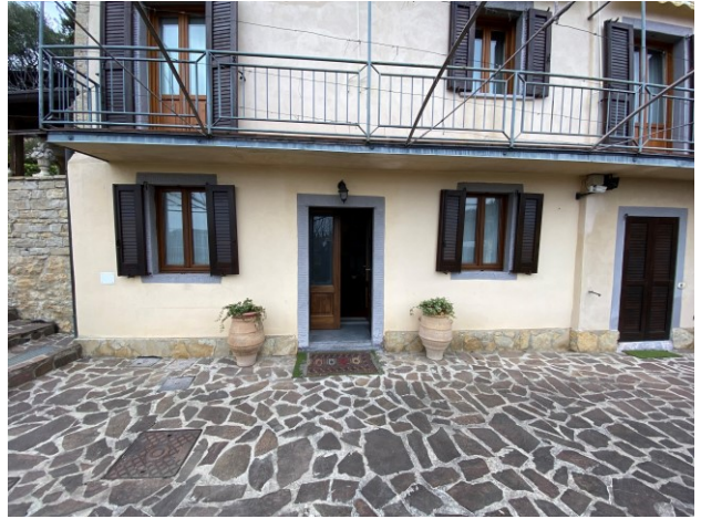
Foto08 vista esterna sub.702
