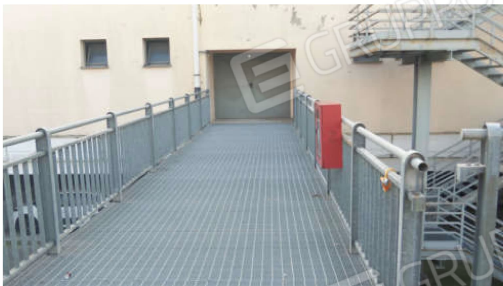
Vista uscita su via Rosmini del corridoio sub 316 (uscita di sicurezza)
