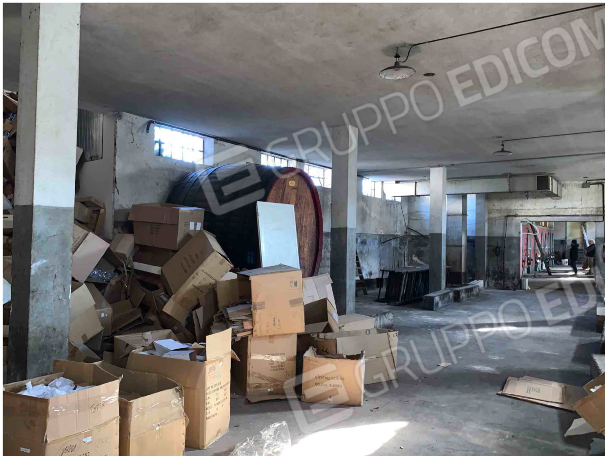
Vista del seminterrato (fotografia del 11.02.2020)
