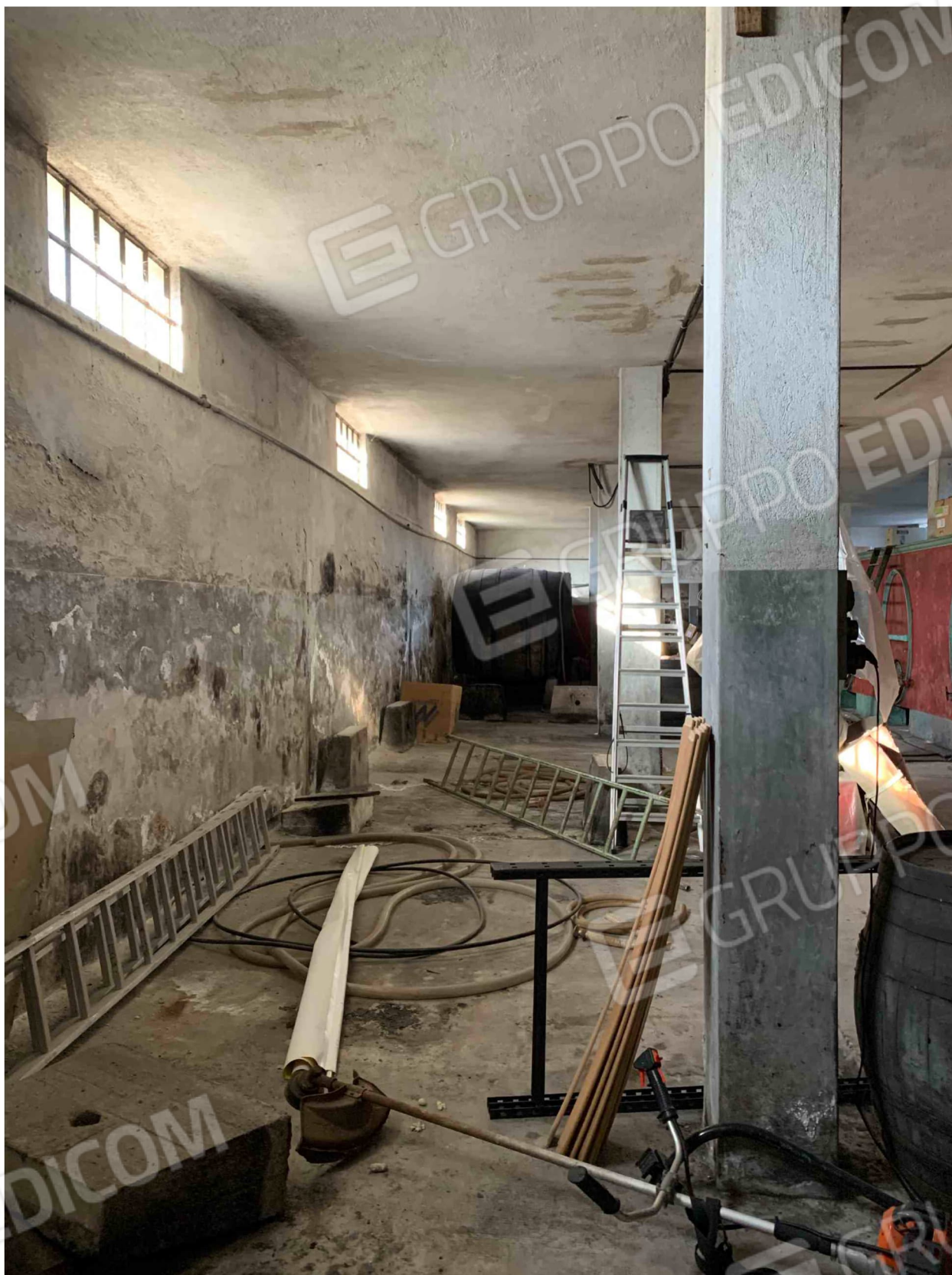
Vista del seminterrato (fotografia del 11.02.2020)
