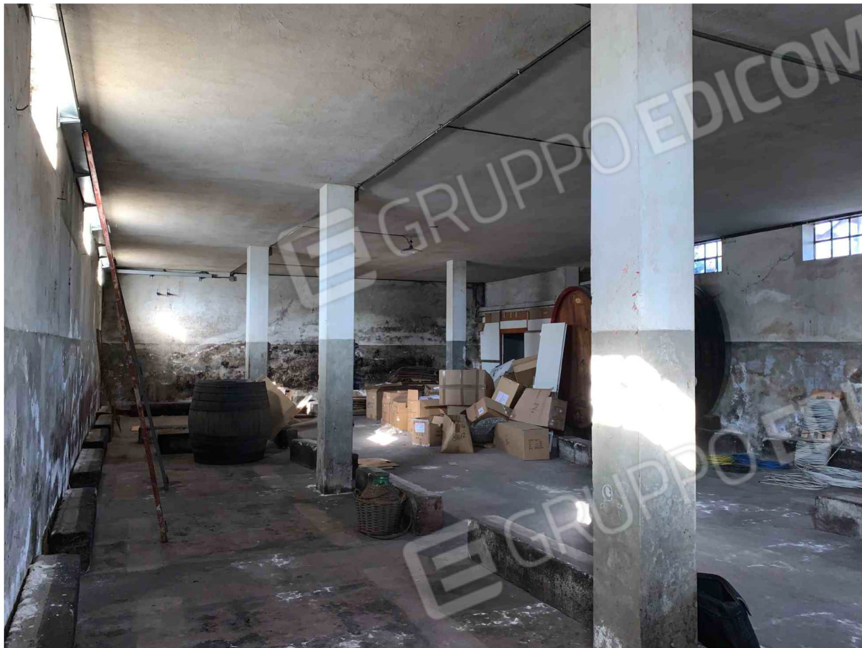
Vista del seminterrato (fotografia del 11.02.2020)
