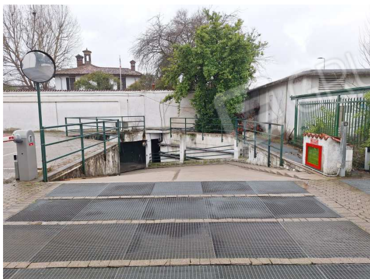
Rampa di discesa ai box interrati
