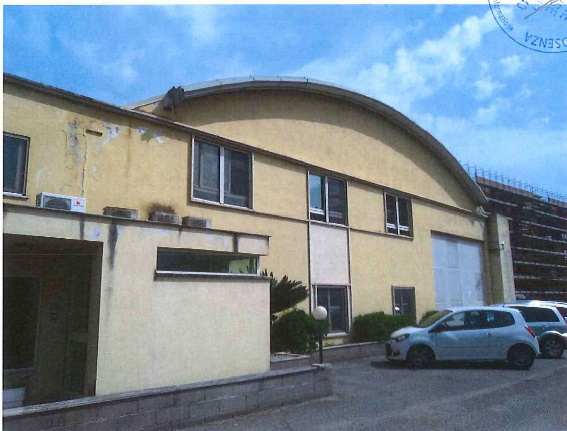
Foto 34: Castiglione Cos. – Capannone Industriale – Vista ovest;
