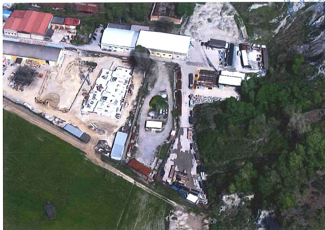
Foto 32: Castiglione Cos. – Capannone Industriale – Vista dall’alto 3D;
