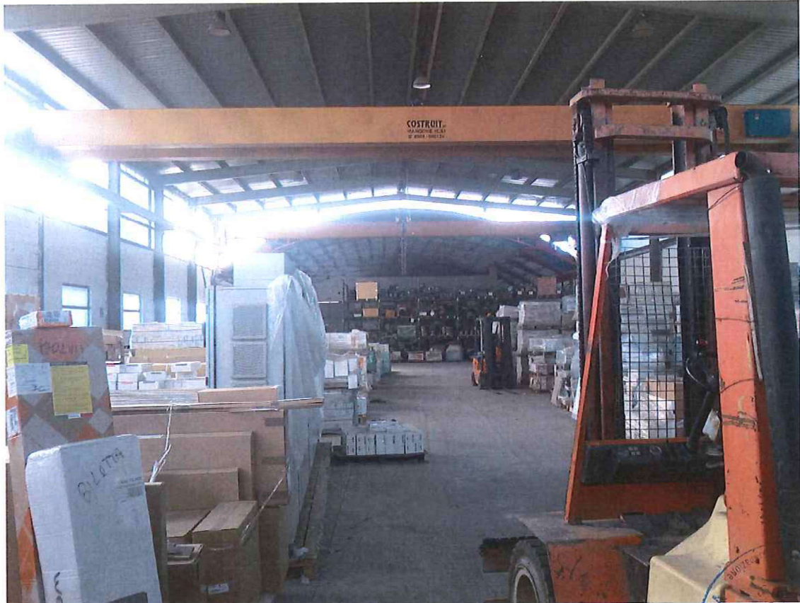
Foto 43: Castiglione Cos. – Capannone Industriale – Area Produzione;
