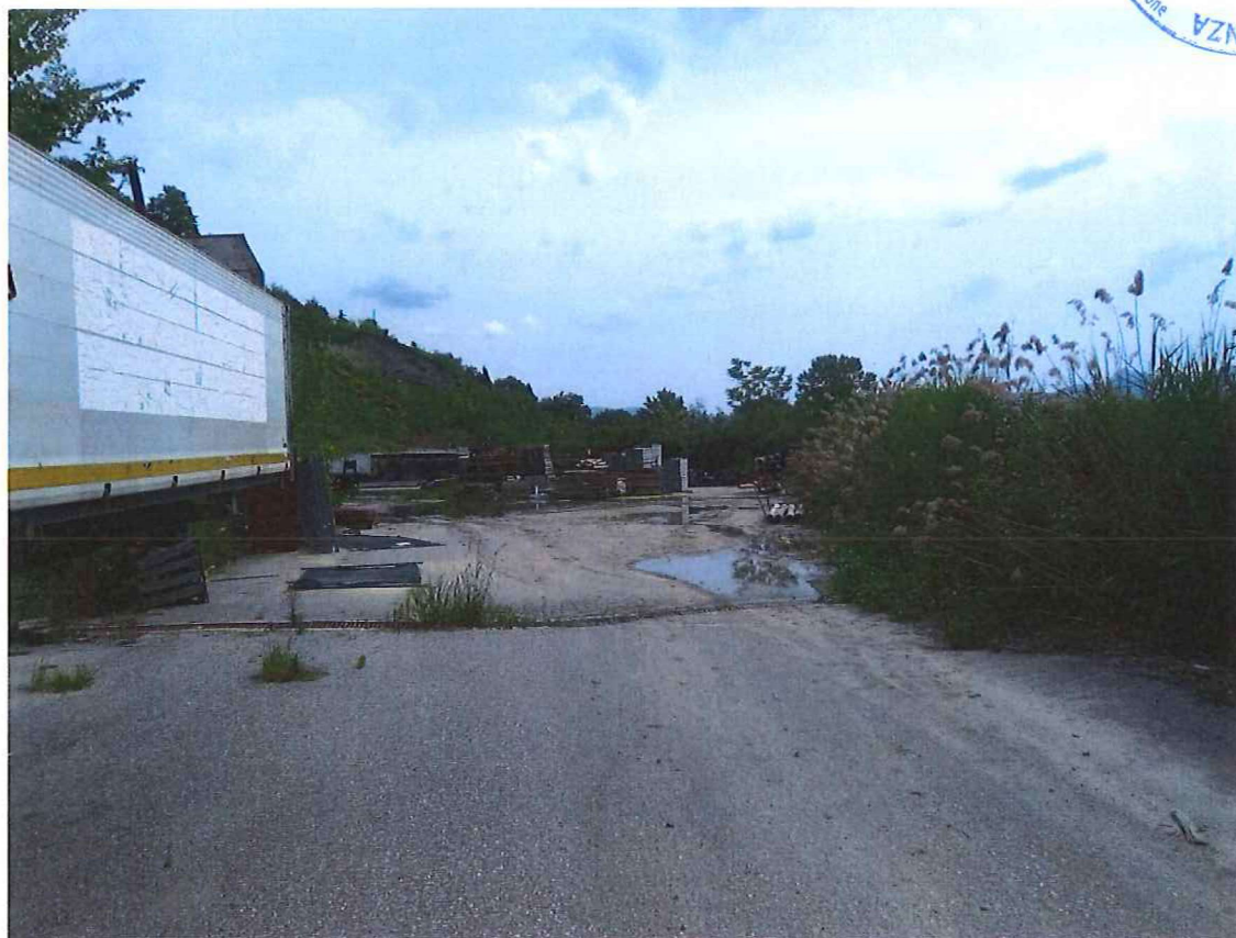
Foto 38: Castiglione Cos. – Capannone Industriale – Corte esterna;
