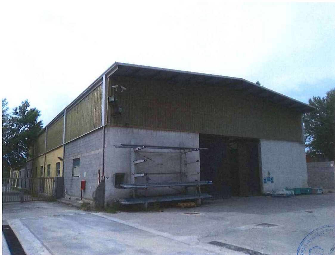
Foto 35: Castiglione Cos. – Capannone Industriale – Vista sud-est;
