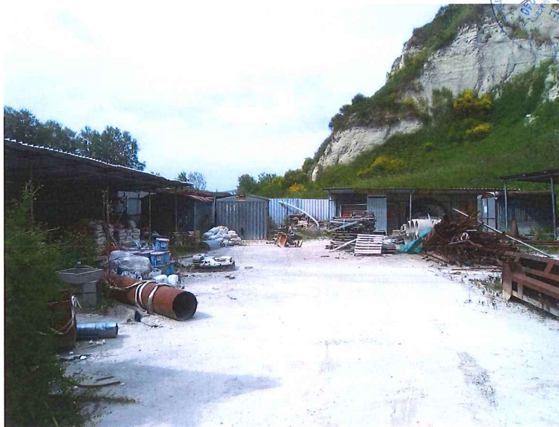
Foto 40: Castiglione Cos. – Capannone Industriale – Corte esterna;
