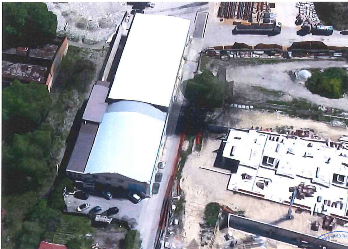
Foto 33: Castiglione Cos. – Capannone Industriale – Vista dall’alto 3D;
