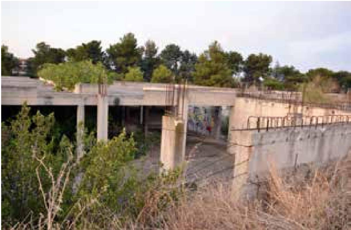
Foto n.6: Vista del lotto in stima da sud/ovest verso nord/est in corrispondenza della p.lla 330 interessata dalle strutture parziali di fondazione e del piano interrato della RSA
