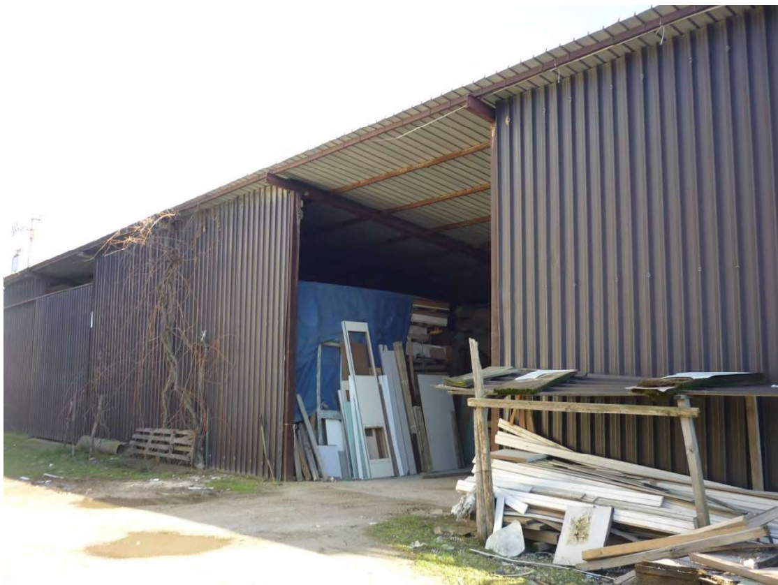
Figura 48 - Struttura lato Sud
