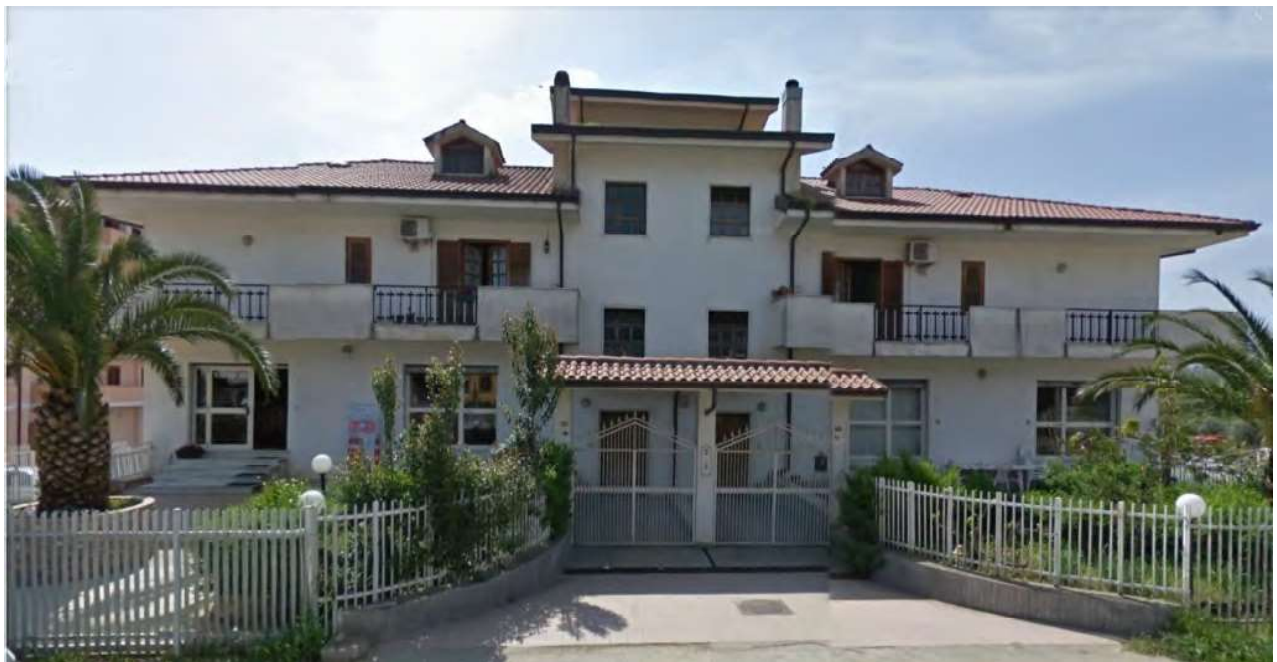
Figura 2– Vista lato nord fabbricato- fronte strada
