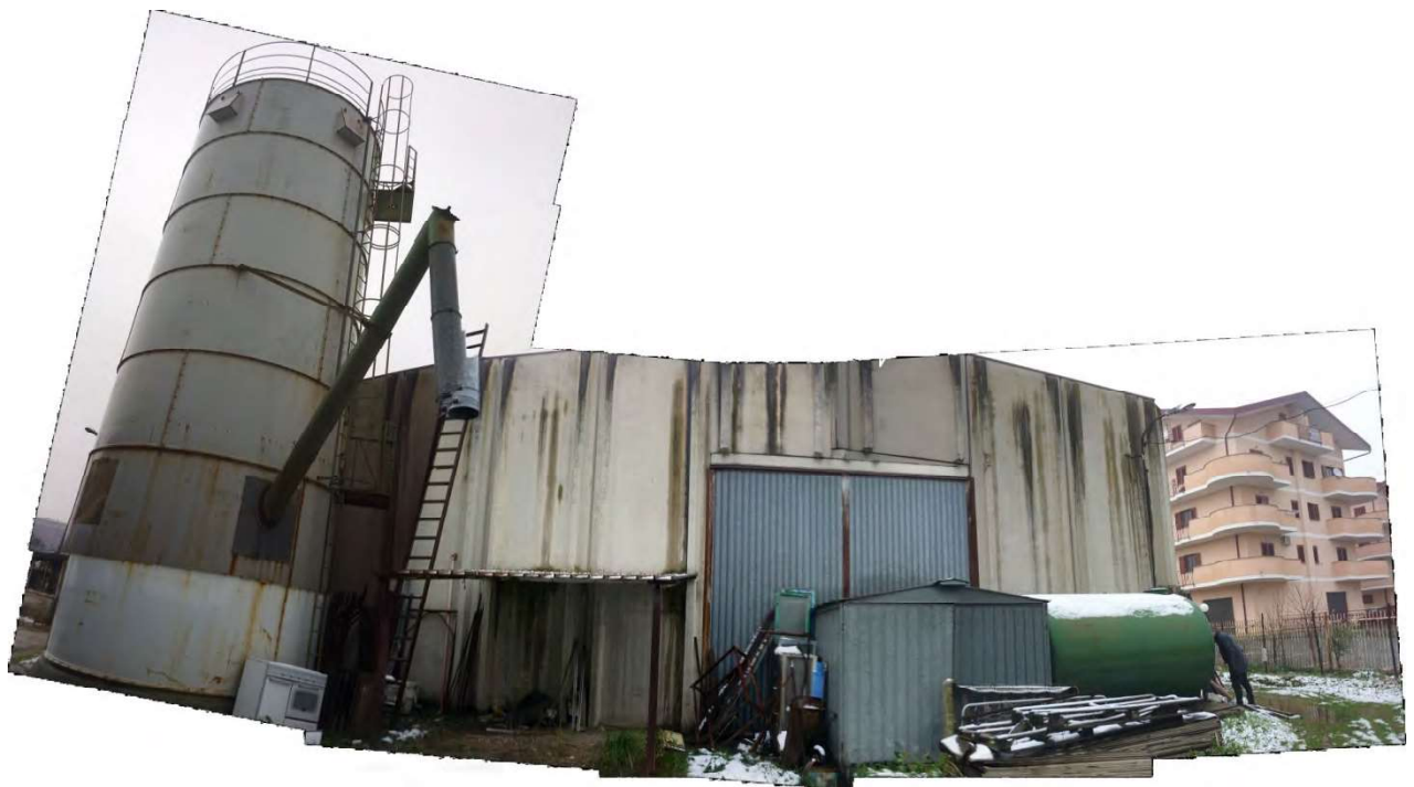
Figura 46– Vista lato sud Capannone
