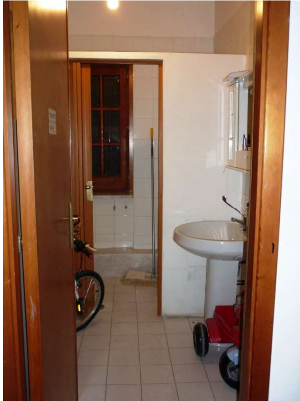
Figura 15 – Particolare WC n°1 Tabaccheria - sub 21
