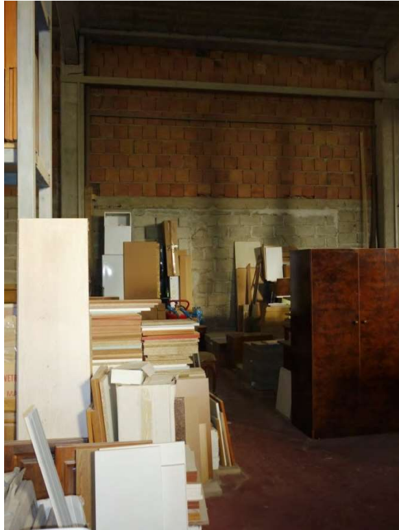
Figura 53 – Vista interna sub 17
