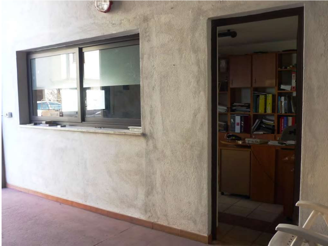
Figura 61 – Vista ufficio n°1 sub 18
