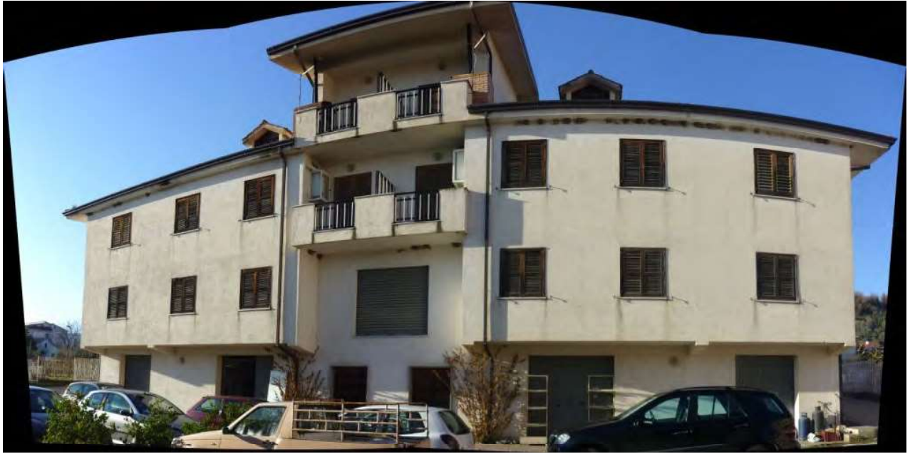
Figura 1– Vista lato sud Fabbricato- corte interna
