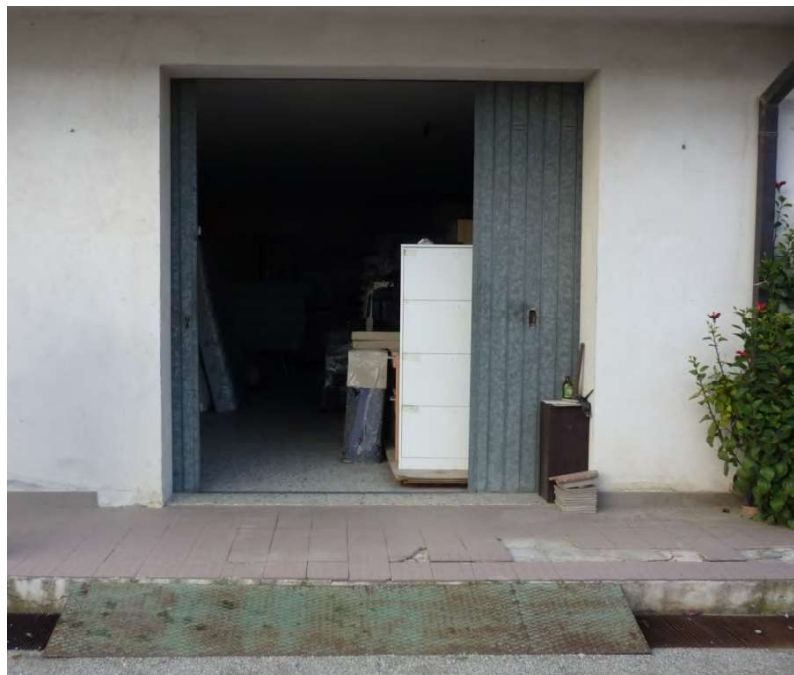
Figura 6 – Vista esterna sub 1-particolare portellone e rampa d'ingresso
