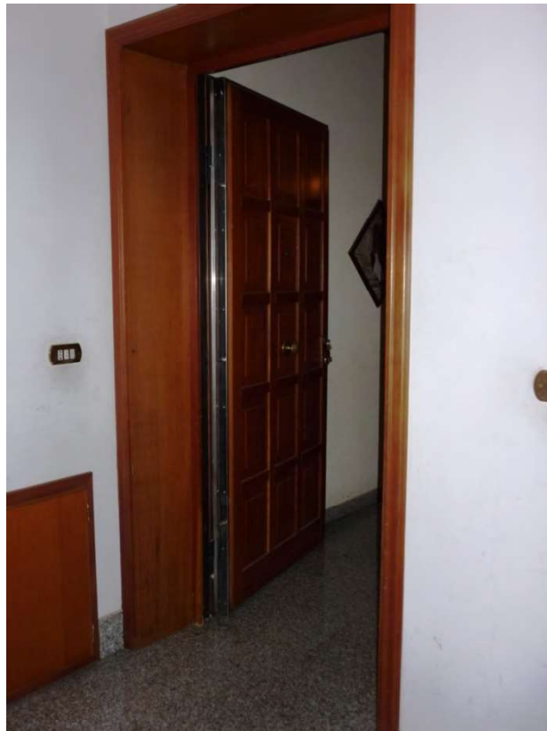
Figura 22 – Particolare porta del bagno -Sub 4
