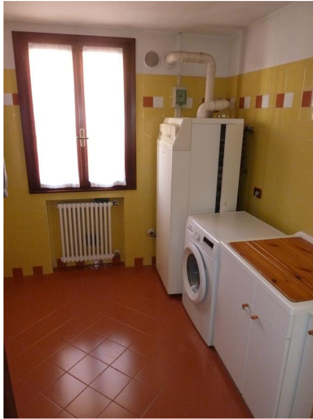
8. Piano Terra – W.c. (adibito C.T.- Lavanderia)
