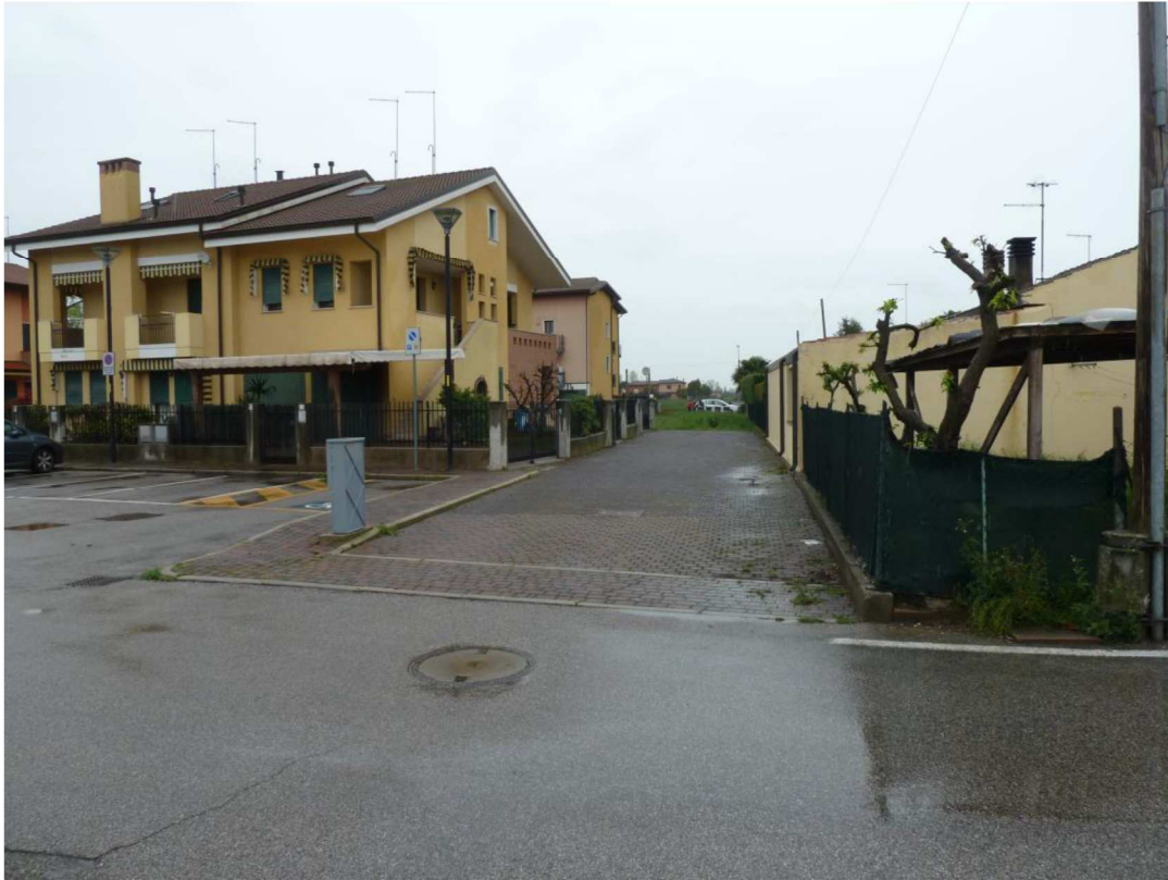
1. Accesso da Via Val Camonica su vialetto gravato da servitù a favore del lotto n.2
