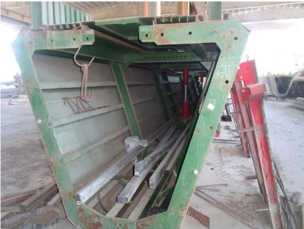
**Foto n. 9:** Primo tampone con elementi di confino per cassero a “V” 160 – 180.
