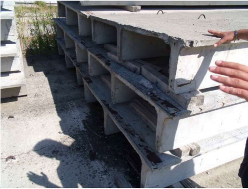
Foto n. 39: Tre coppelle prefabbricate
