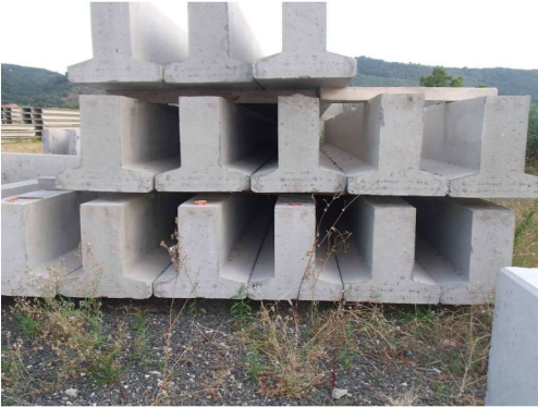
Foto n. 30: Quattordici travi prefabbricate di fondazione reggi-pannello
