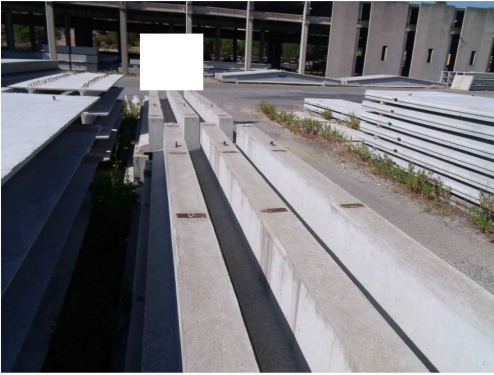
Foto n. 45: Numero quattordici travi reggi-pannello prefabbricate
