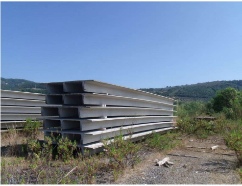
Foto n. 38: Cinque coppelle prefabbricate tri-nervate
