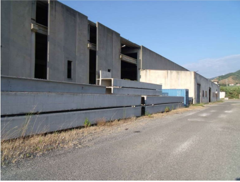
Foto n. 73: Copponi prefabbricati binervati
