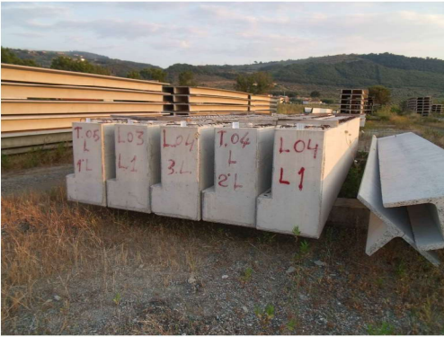
Foto n. 34: Cinque travi prefabbricate
