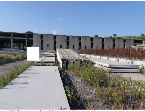
Foto n. 68: Quattro travi prefabbricate a doppia pendenza
