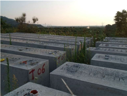
Foto n. 32: Travi prefabbricate a T
