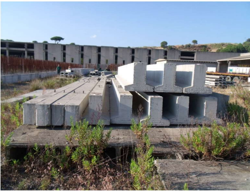
Foto n. 70: Sulla destra travi prefabbricate reggi-pannello, sulla sinistra travi rettangolari prefabbricate di collegamento
