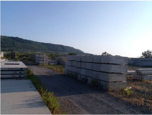
Foto n. 76: Basi per fondazioni di recinzione; sulla destra della foto è possibile osservare i pilastri di recinzione.
