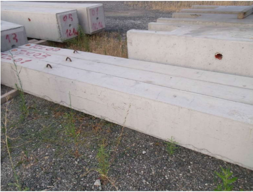
Foto n. 25: Travi prefabbricate di collegamento di fondazione
