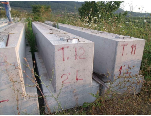
Foto n. 31: Travi prefabbricate a "T", indicate con i simboli T11-1L e T12-2L.
