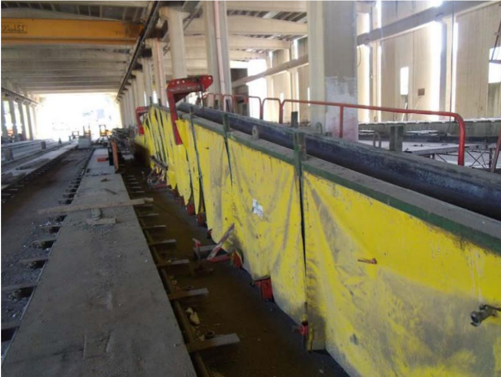
Foto n. 23: Due sponde per travi a doppia pendenza
