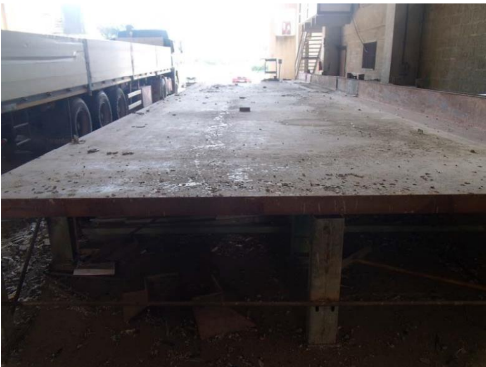
Foto n. 38: Banco da lavoro.
